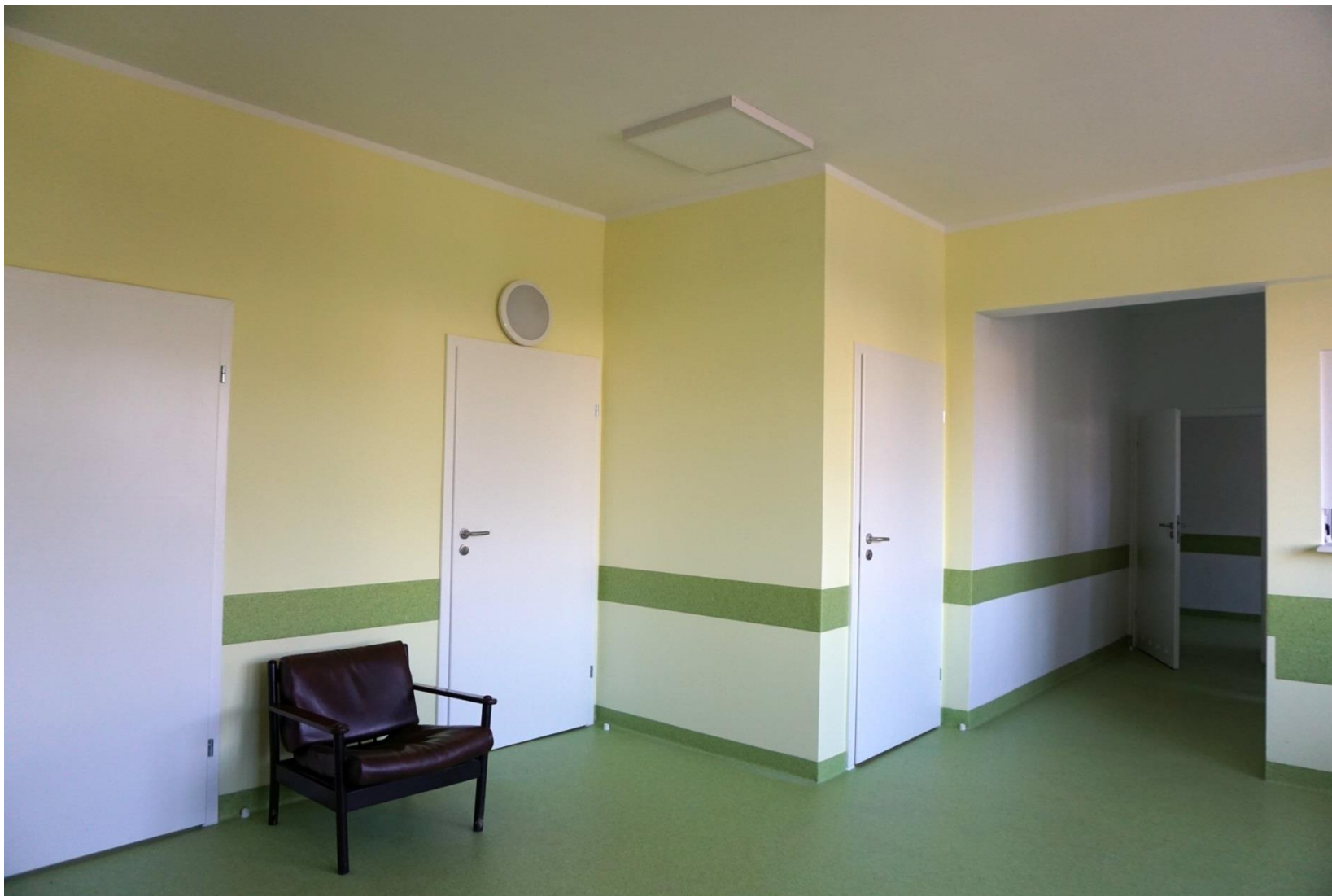
Remont ośrodka zdrowia w Grzegorzewie
