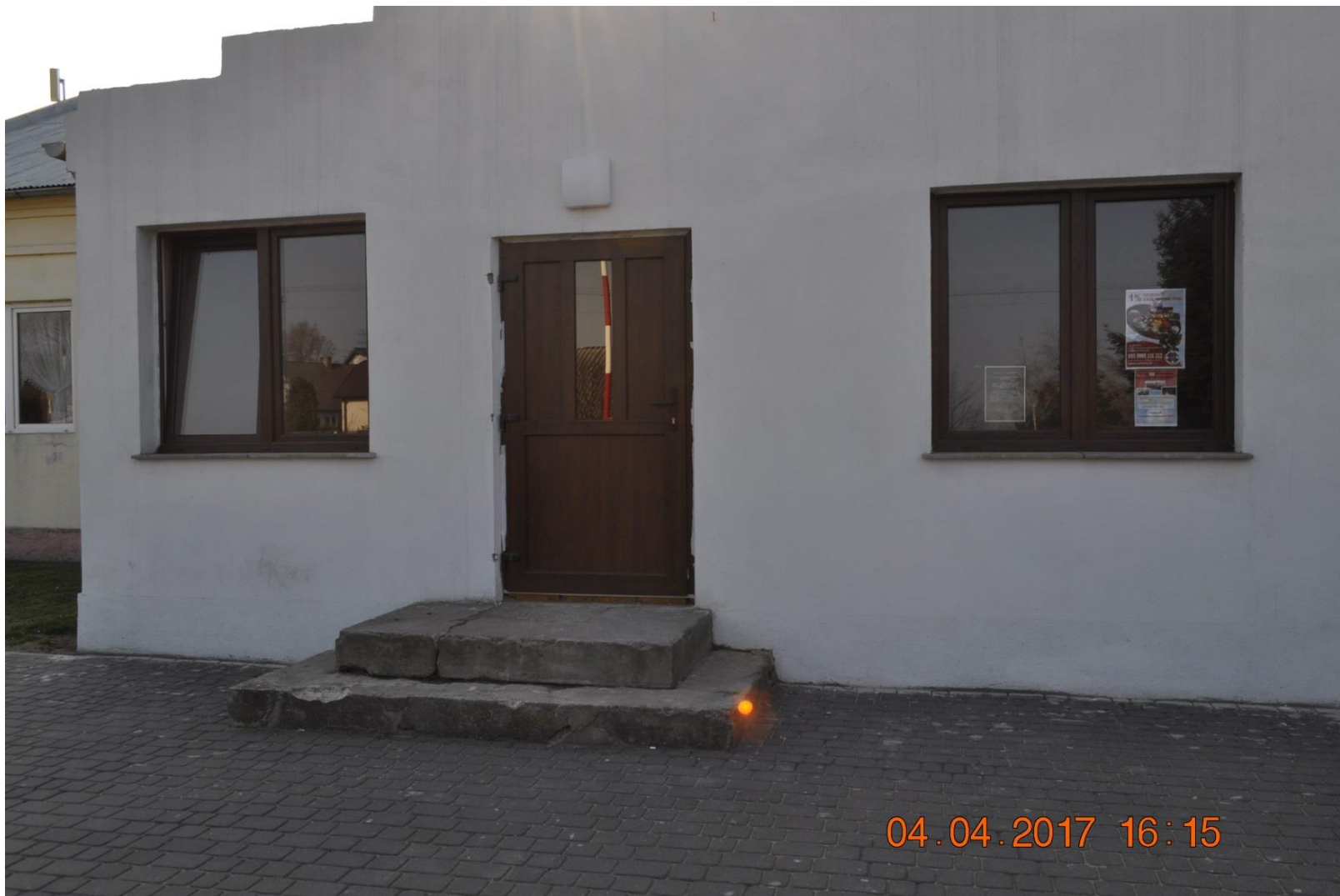
Montaż drzwi w Remizie OSP w Barłogach
