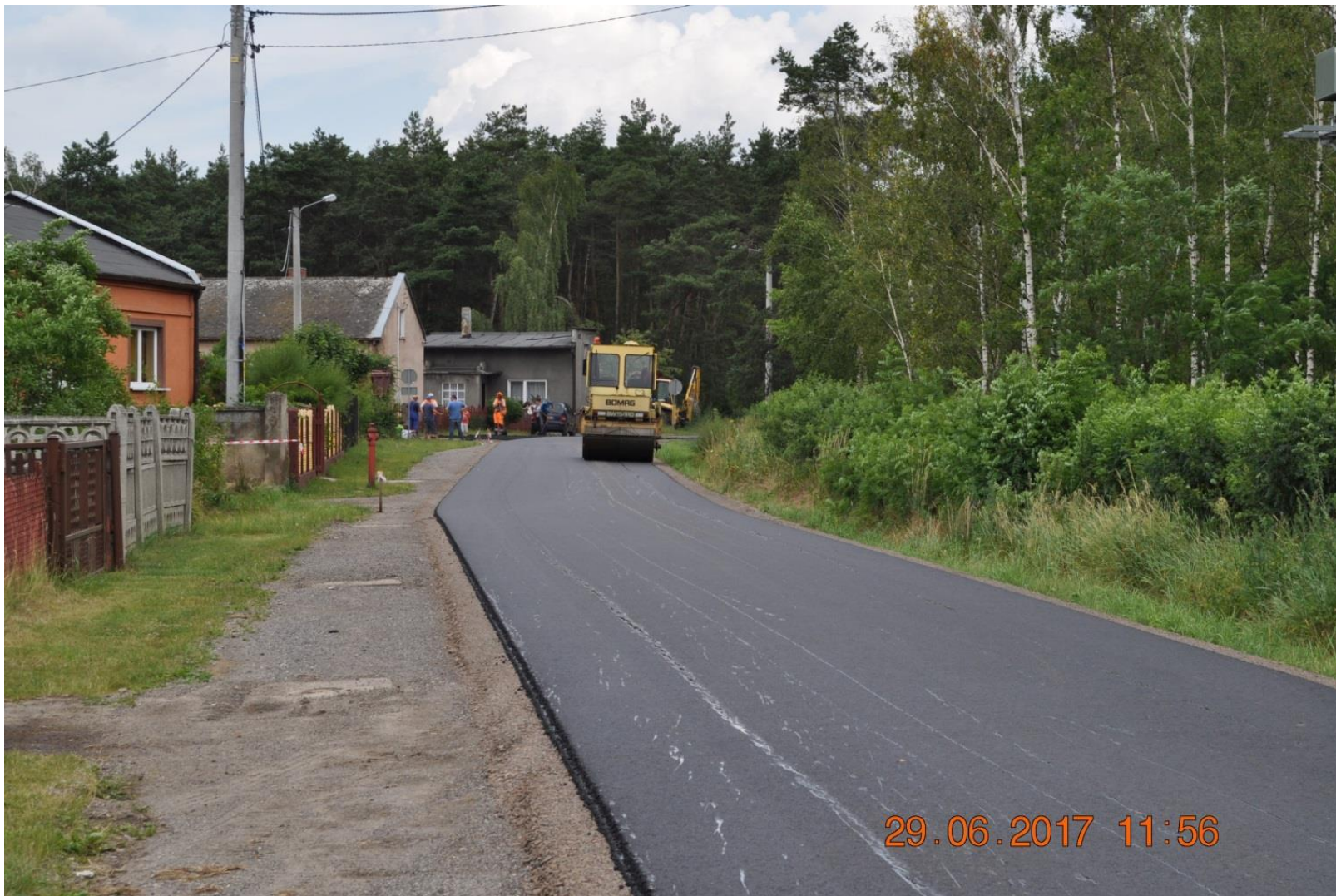
Przebudowa ulicy Piaski w Grzegorzewie
