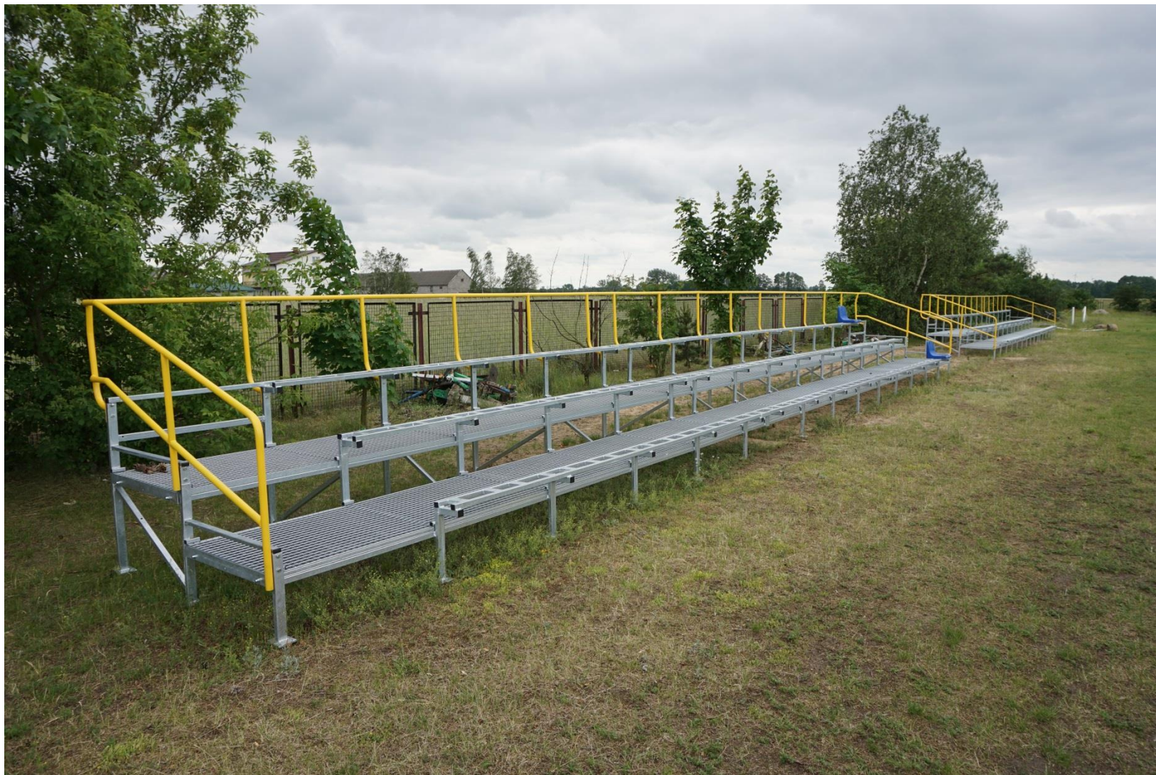
Wykonanie trybun na Stadionie Sportowym w Barłogach
