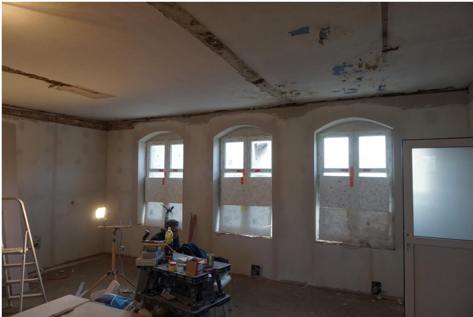
Remont budynku ul. Warszawska 23 - Klub "Senior +"
