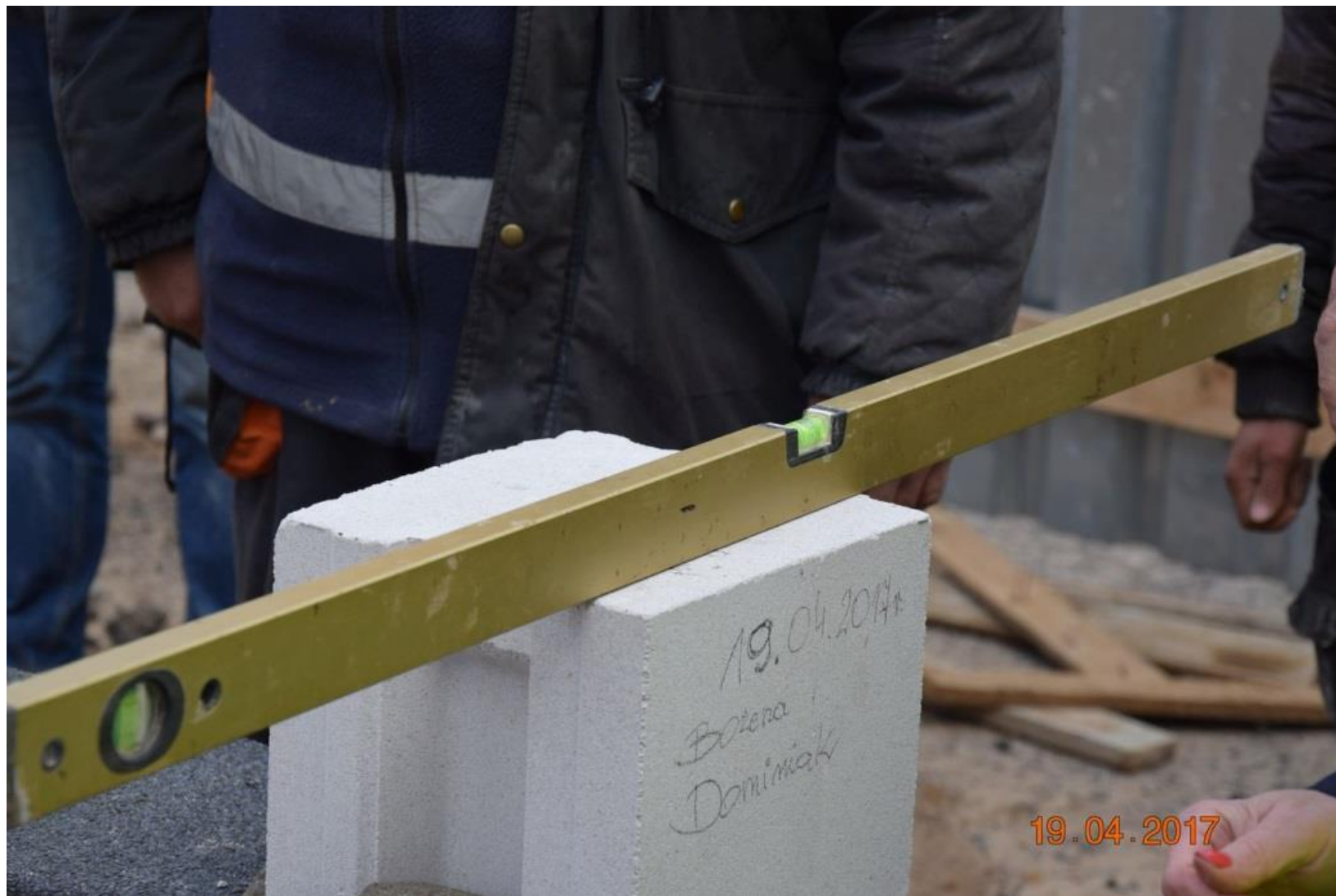
Budowa Środowiskowej Hali Sportowej w Grzegorzewie
