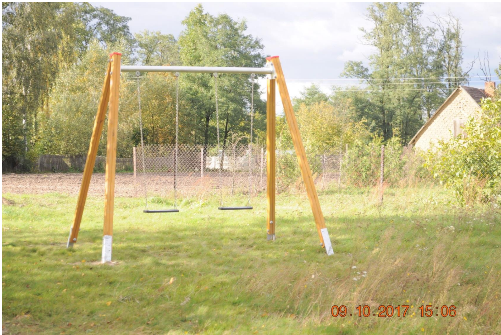
Wykonanie placu zabaw w Boguszyńcu
