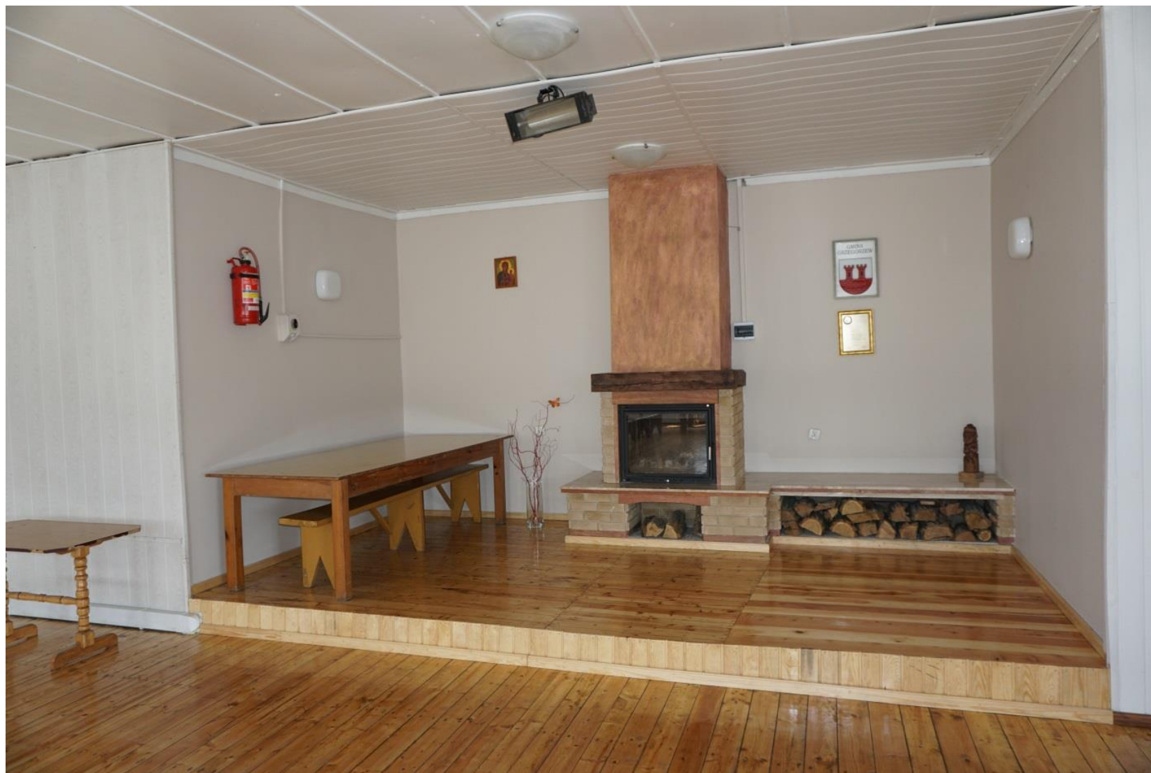
Wykonanie ogrzewania w Strażnicy OSP w Zabłociu oraz cyklinowanie podłogi
