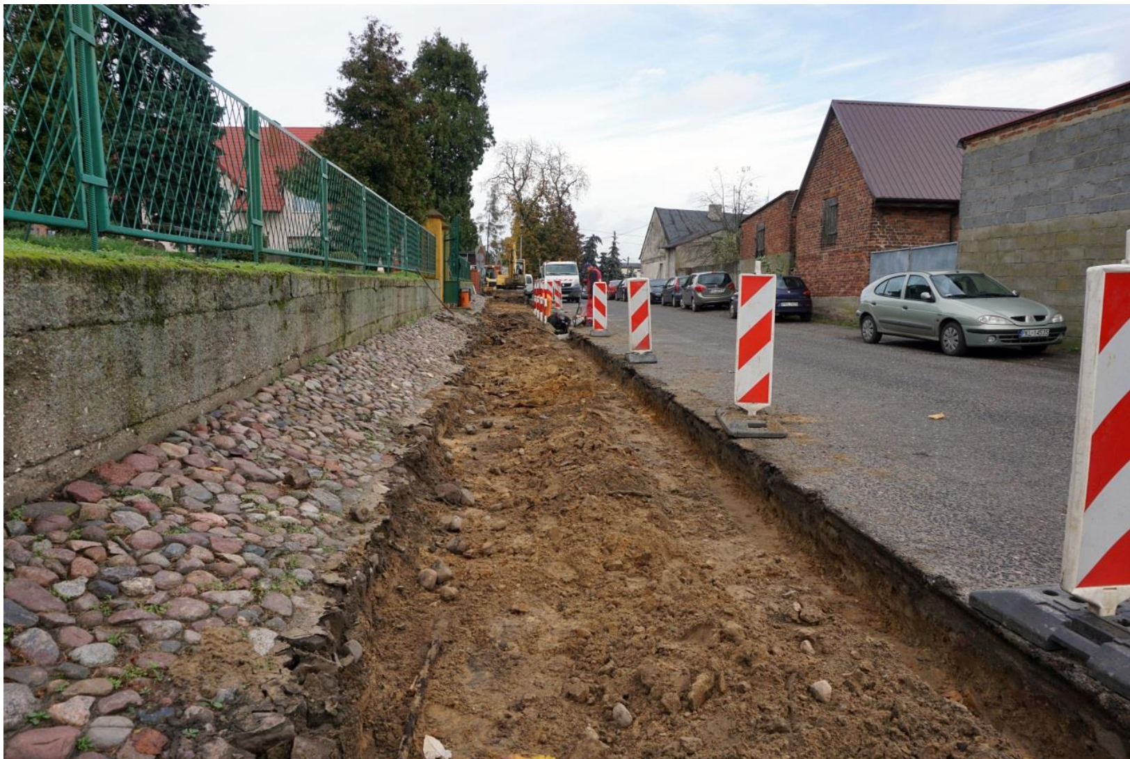
Budowa chodnika przy ulicy Szkolnej w Grzegorzewie
