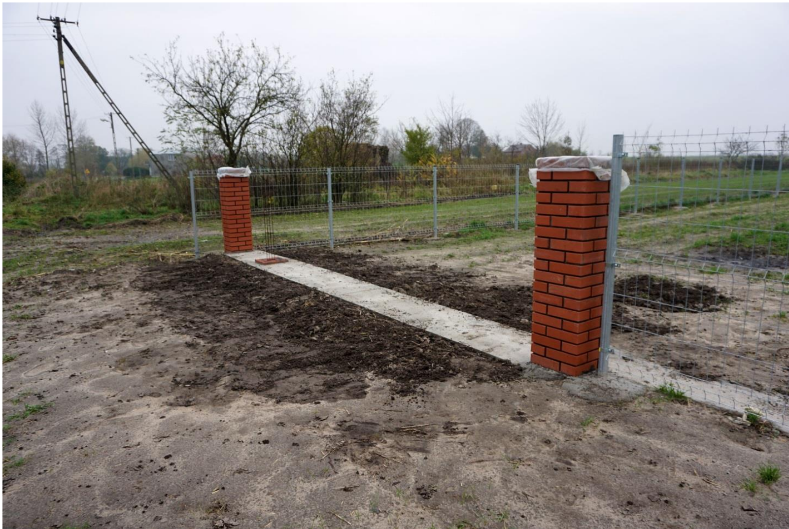
Wykonanie ogrodzenia przy świetlicy wiejskiej w Grodnej
