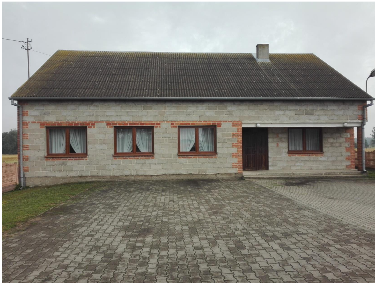
Wymiana okien w Świetlicy Wiejskiej w Ladorudzk
