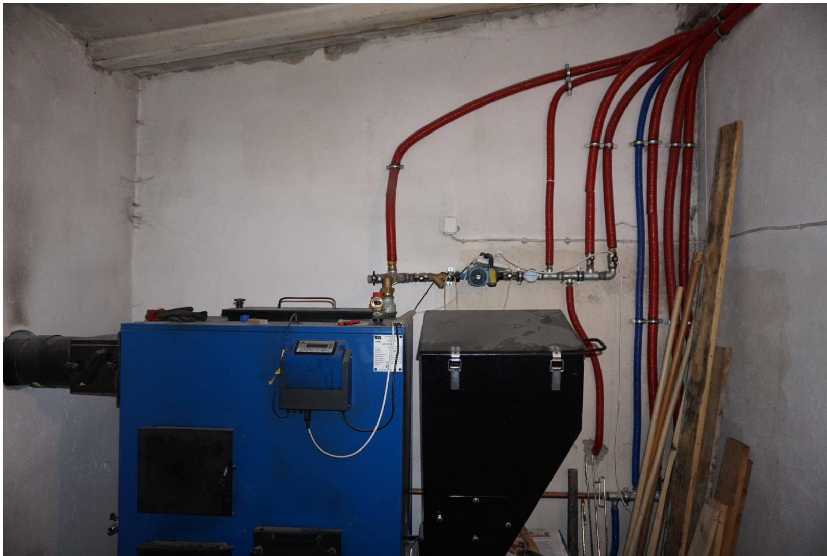
Wykonanie ogrzewania w Remizie OSP w Bylicach
