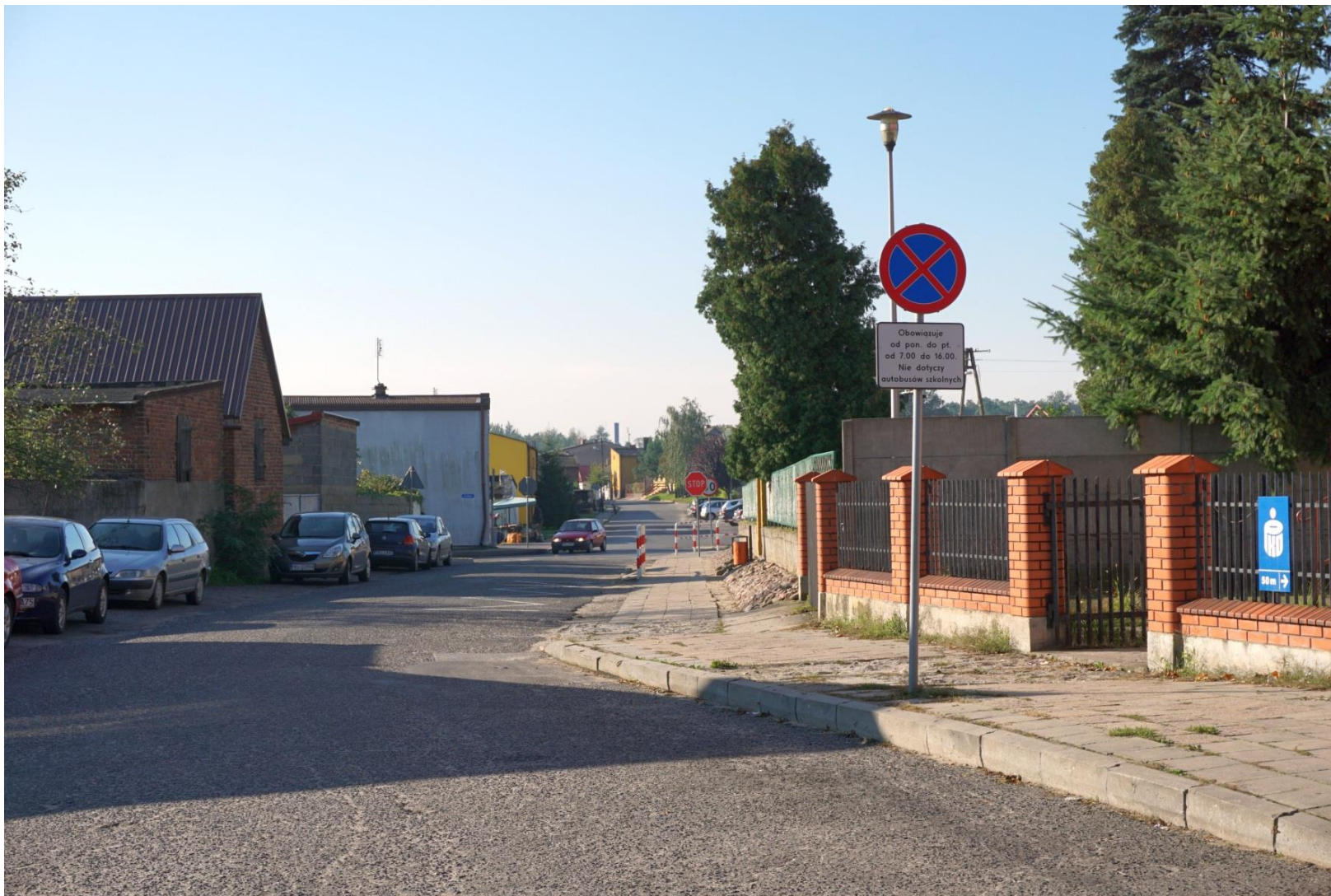
Budowa chodnika przy ulicy Szkolnej w Grzegorzewie
