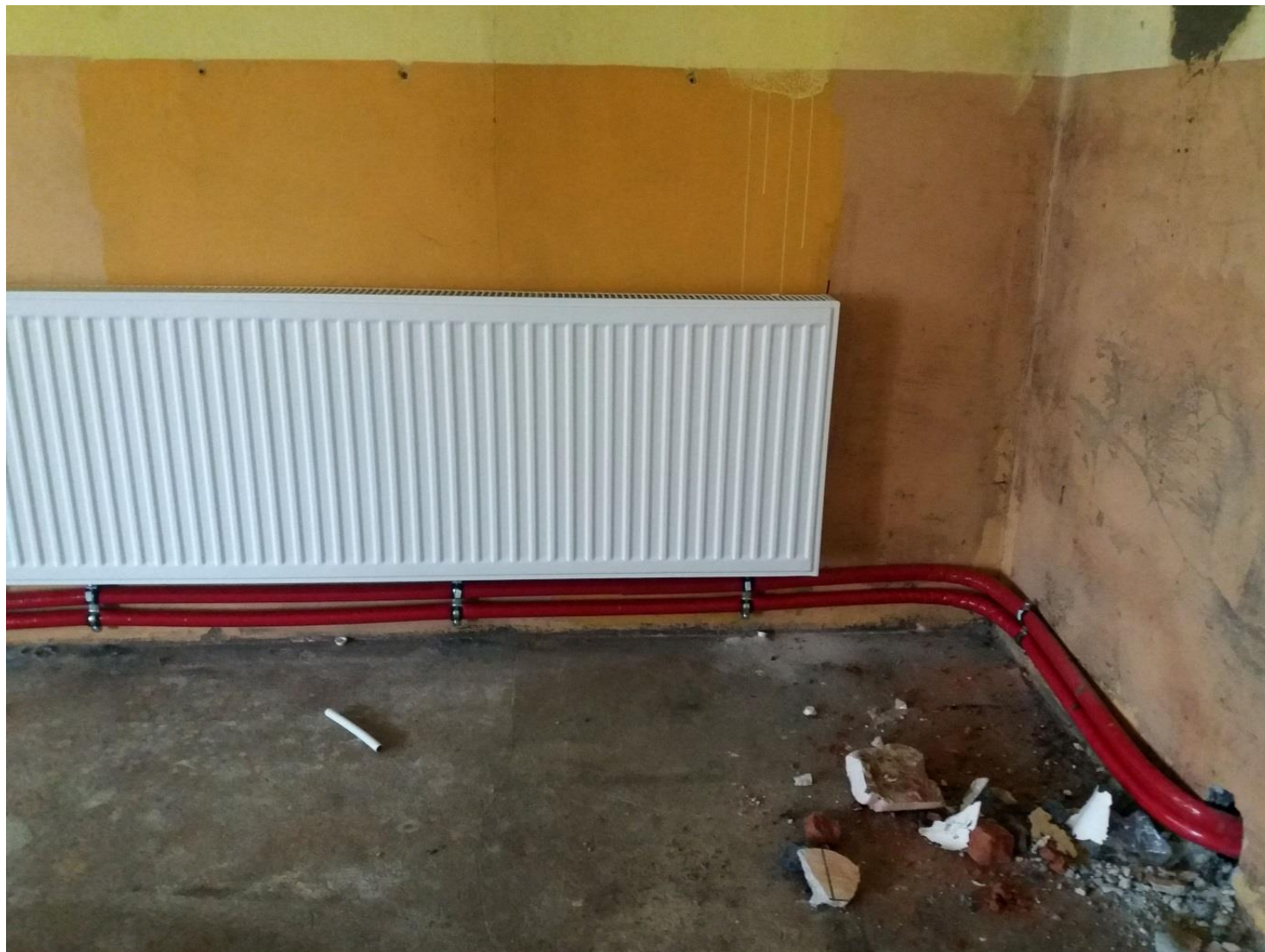
Montaż Ogrzewania w Remizie OSP w Ponętowie Dolnym
