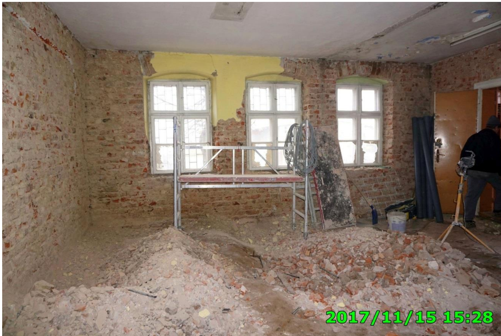
Remont budynku ul. Warszawska 23 - Klub "Senior +"
