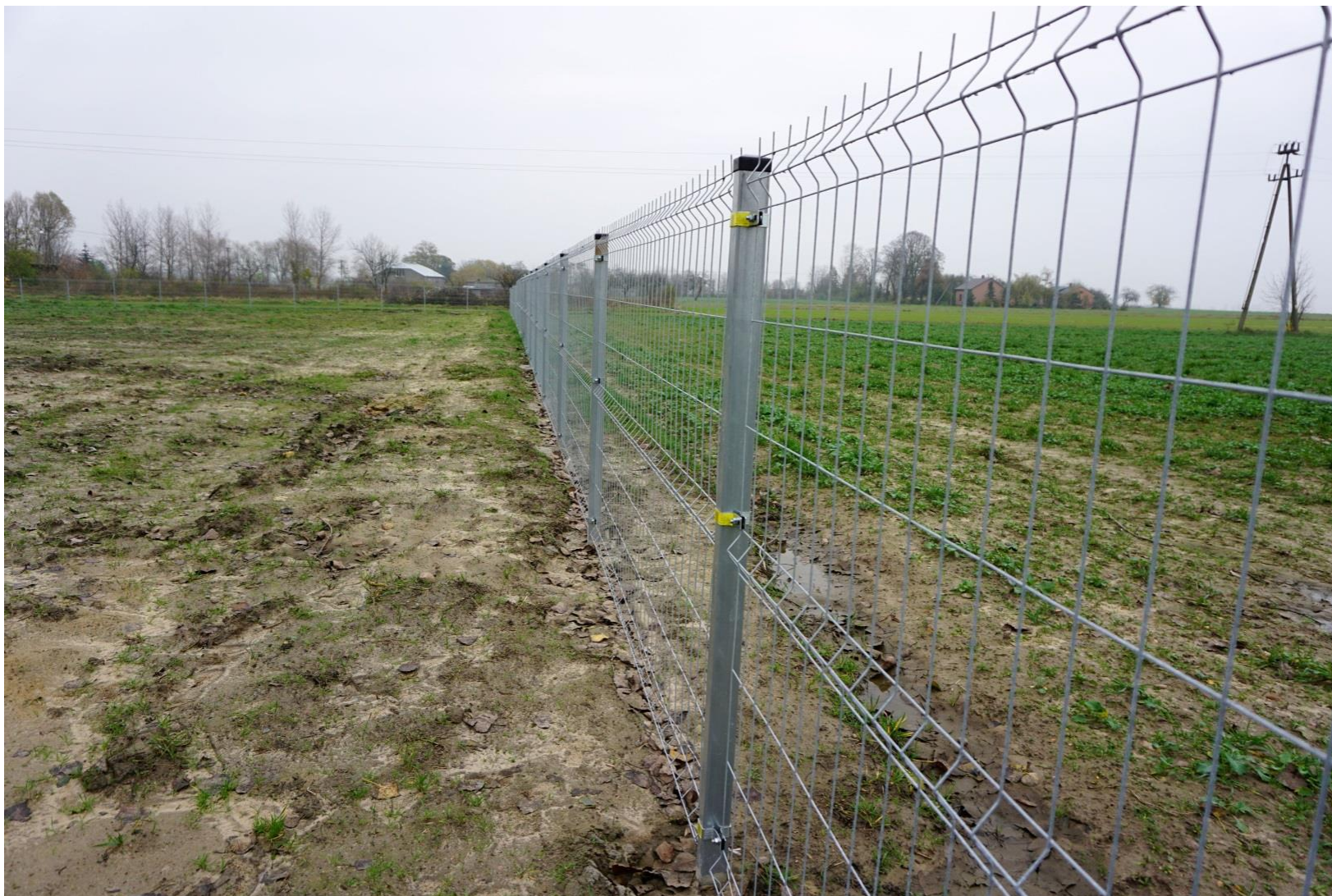
Wykonanie ogrodzenia przy świetlicy wiejskiej w Grodnej
