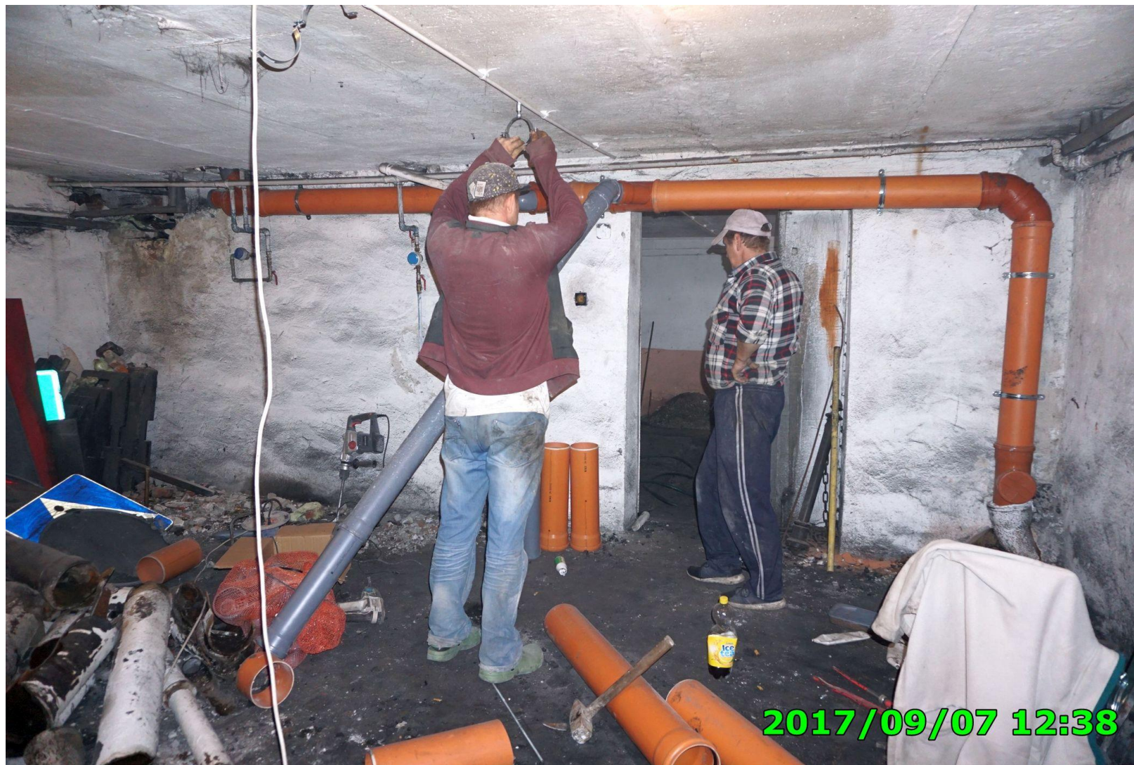
Remont ośrodka zdrowia w Grzegorzewie
