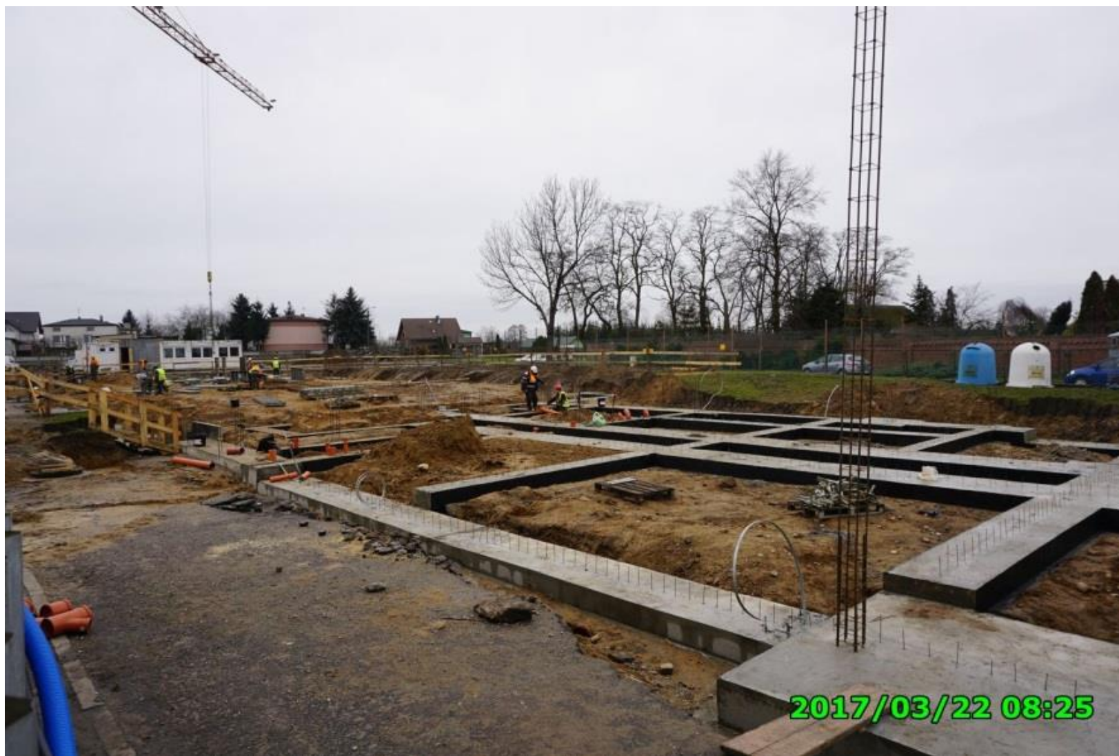
Budowa Środowiskowej Hali Sportowej w Grzegorzewie
