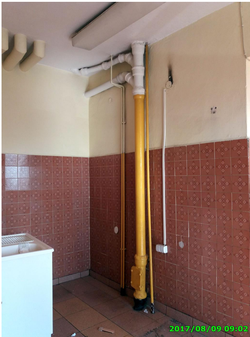
Remont ośrodka zdrowia w Grzegorzewie
