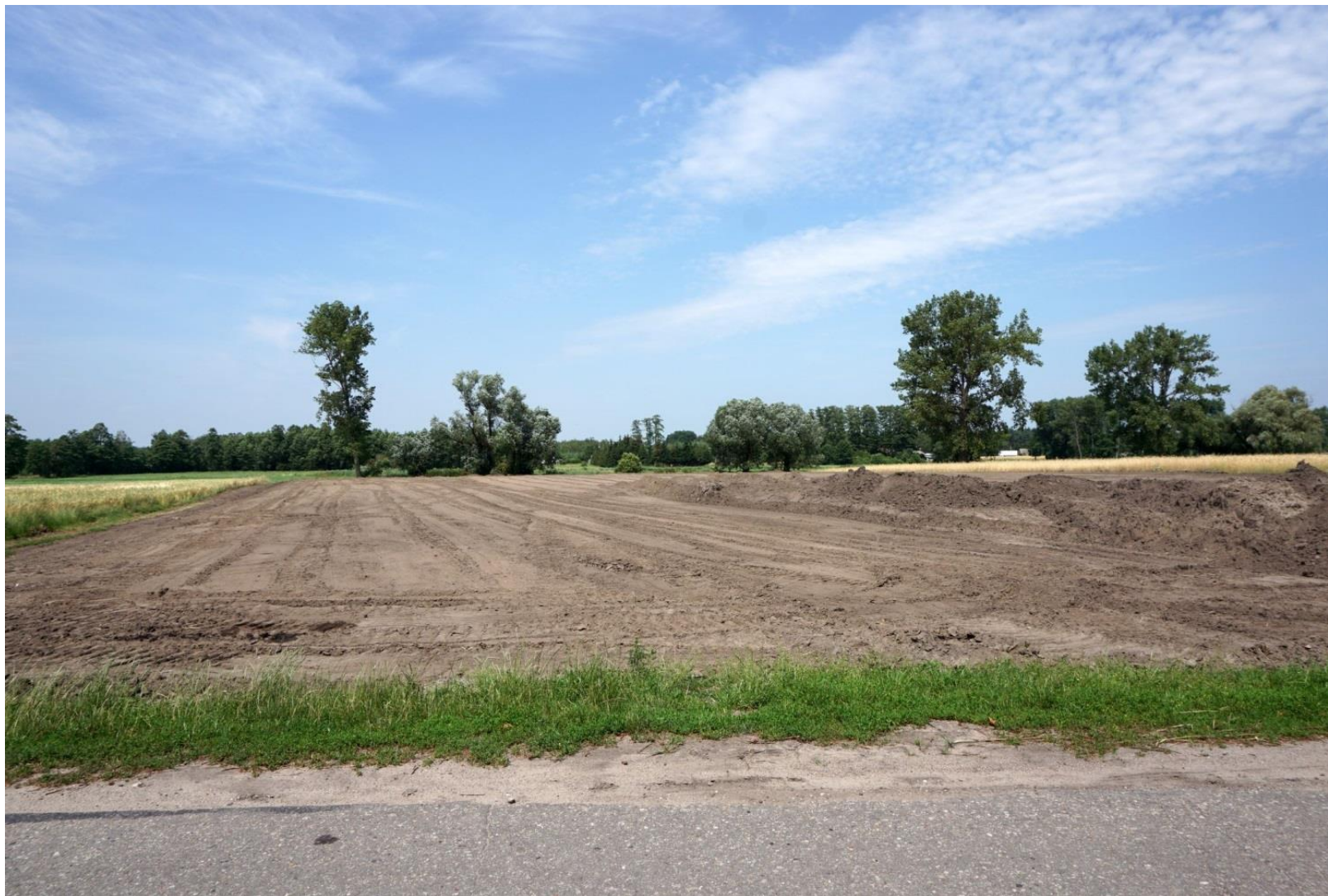
Budowa boiska w Borysławicach Kościelnych
