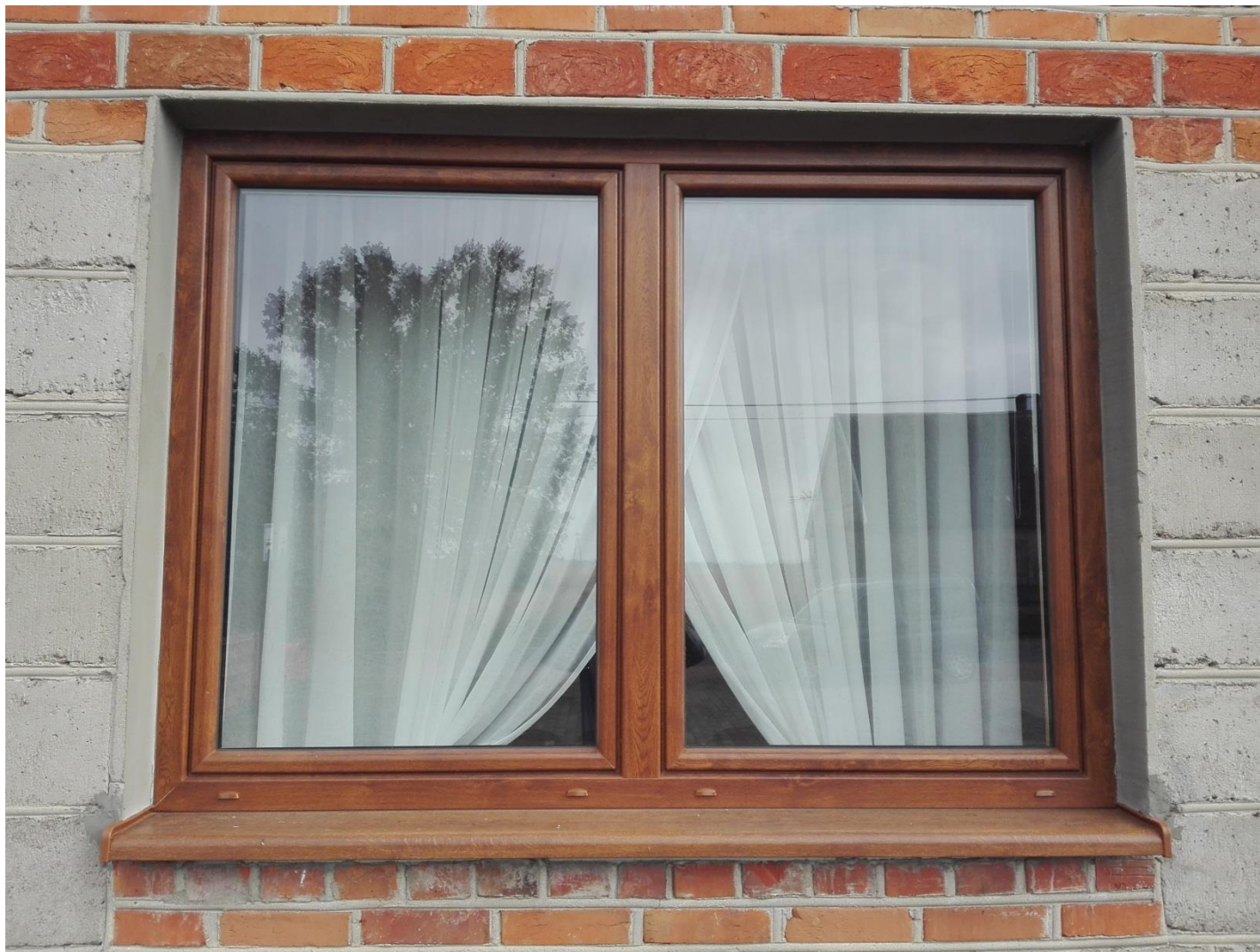
Wymiana okien w Świetlicy Wiejskiej w Ladorudzku
