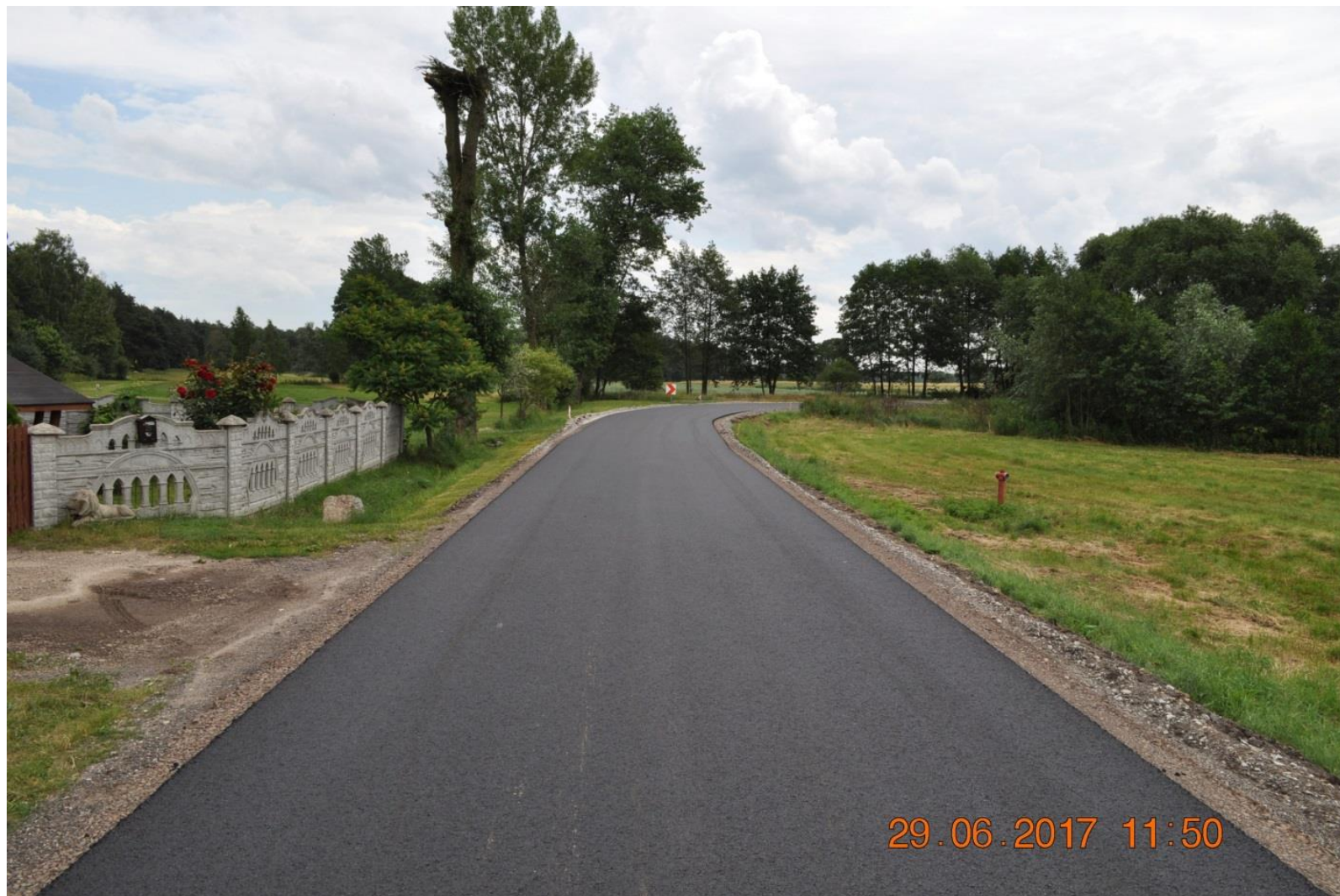
Przebudowa ulicy Piaski w Grzegorzewie
