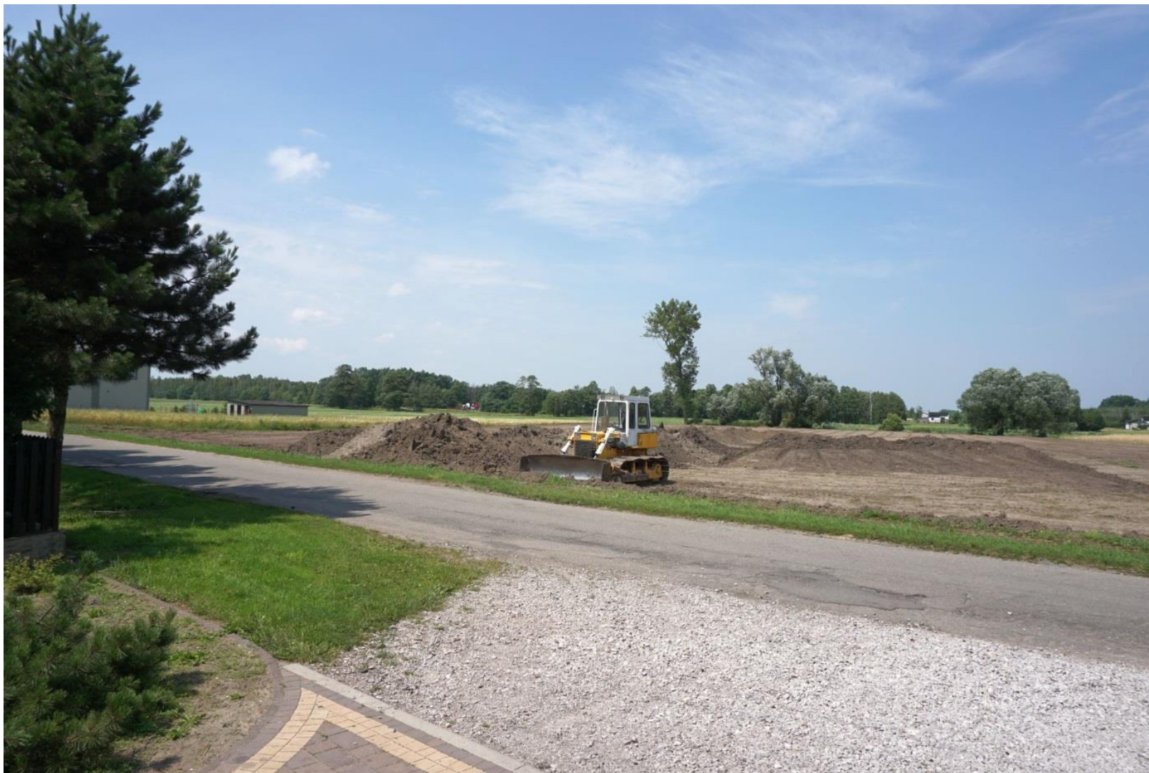
Budowa boiska w Borysławicach Kościelnych
