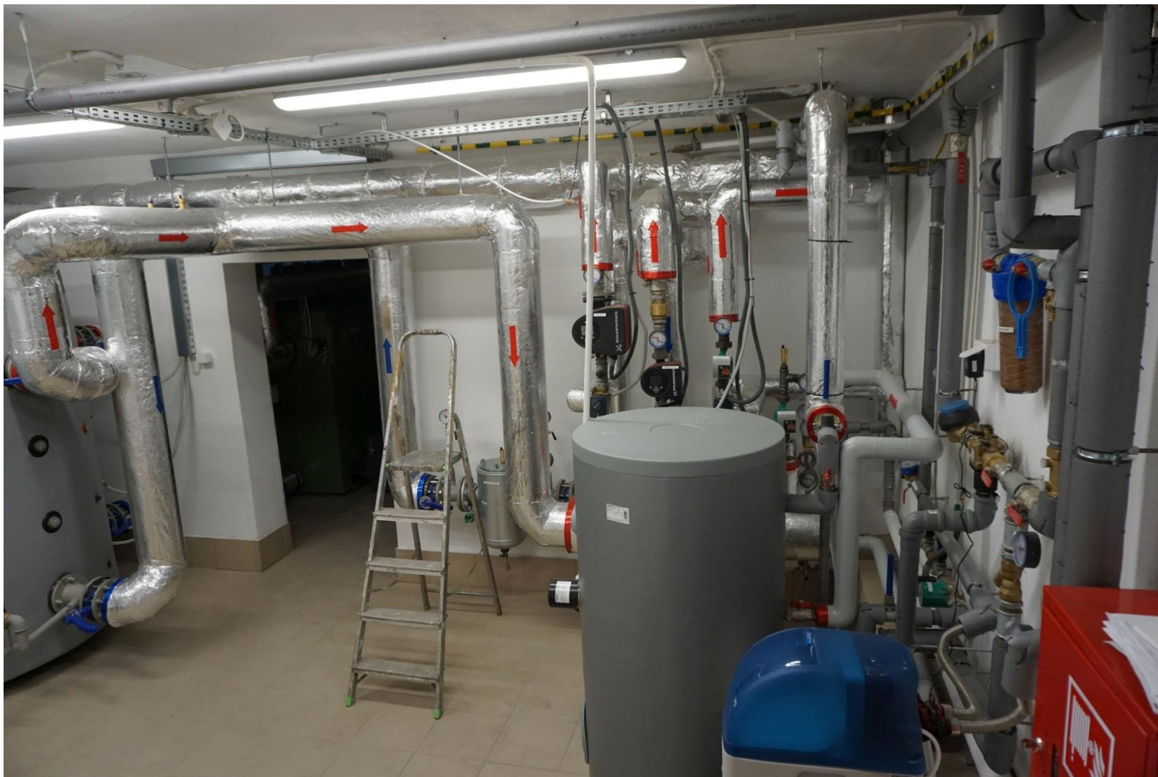
Przebudowa Kotłowni w Zespole Szkolno-Przedszkolnym w Grzegorzewie
