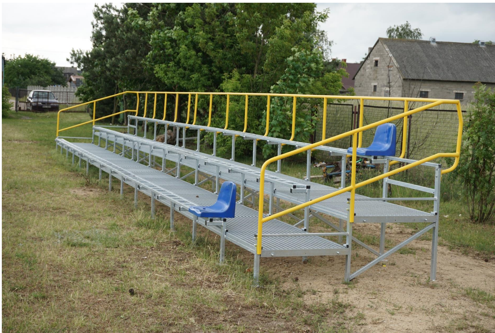
Wykonanie trybun na Stadionie Sportowym w Barłogach
