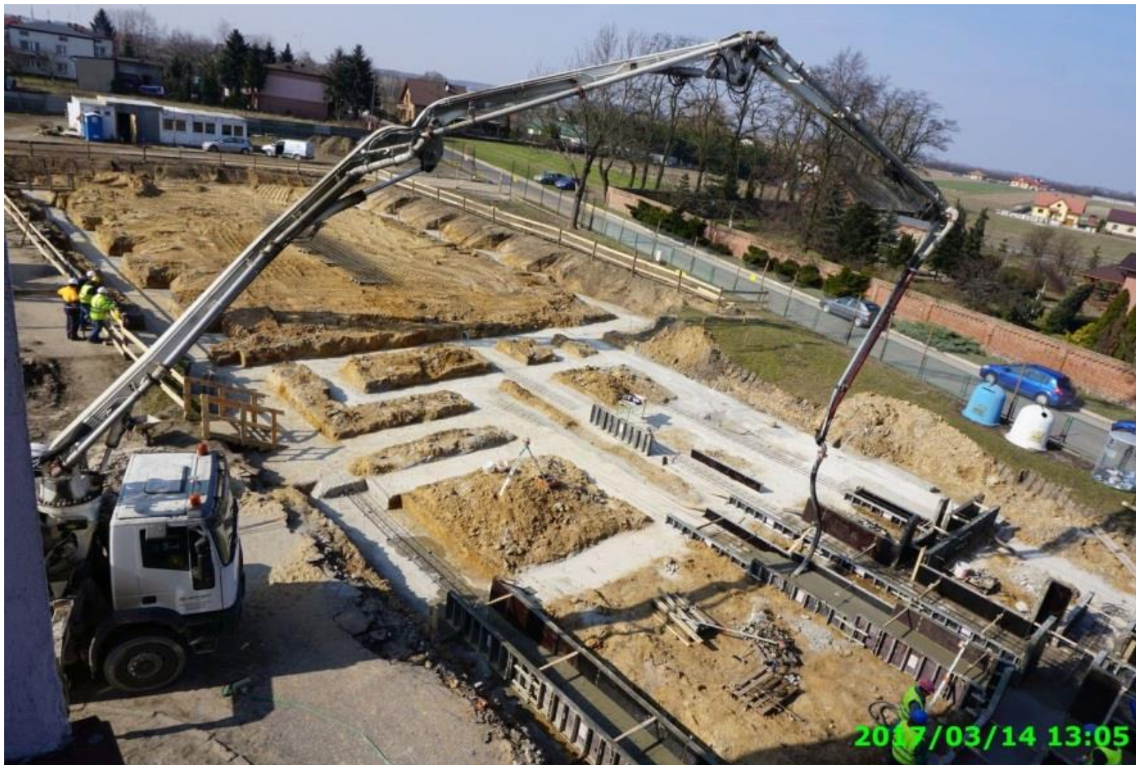
Budowa Środowiskowej Hali Sportowej w Grzegorzewie
