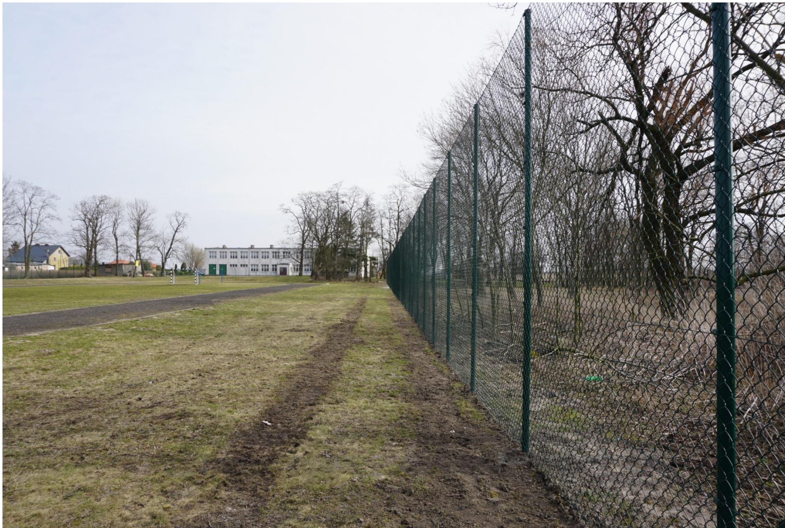
Wykonanie ogrodzenia przy szkole podstawowej w Bylicach-Kolonii
