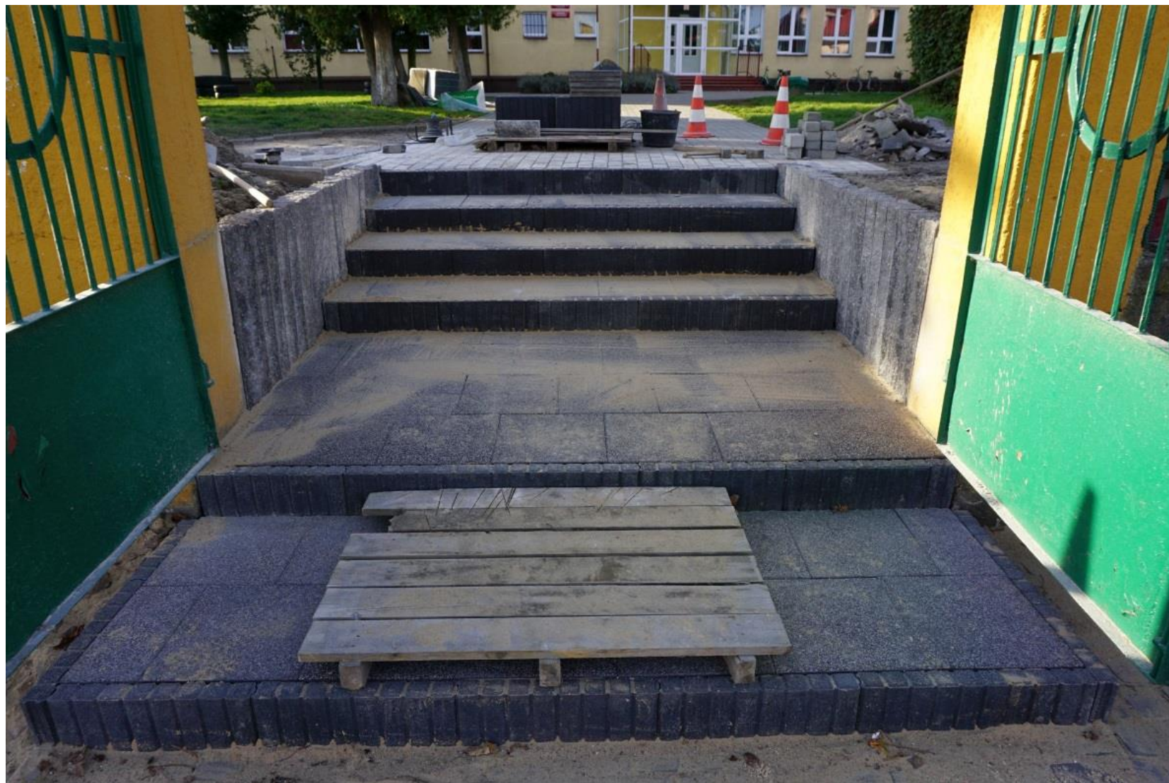
Budowa chodnika przy ulicy Szkolnej w Grzegorzewie
