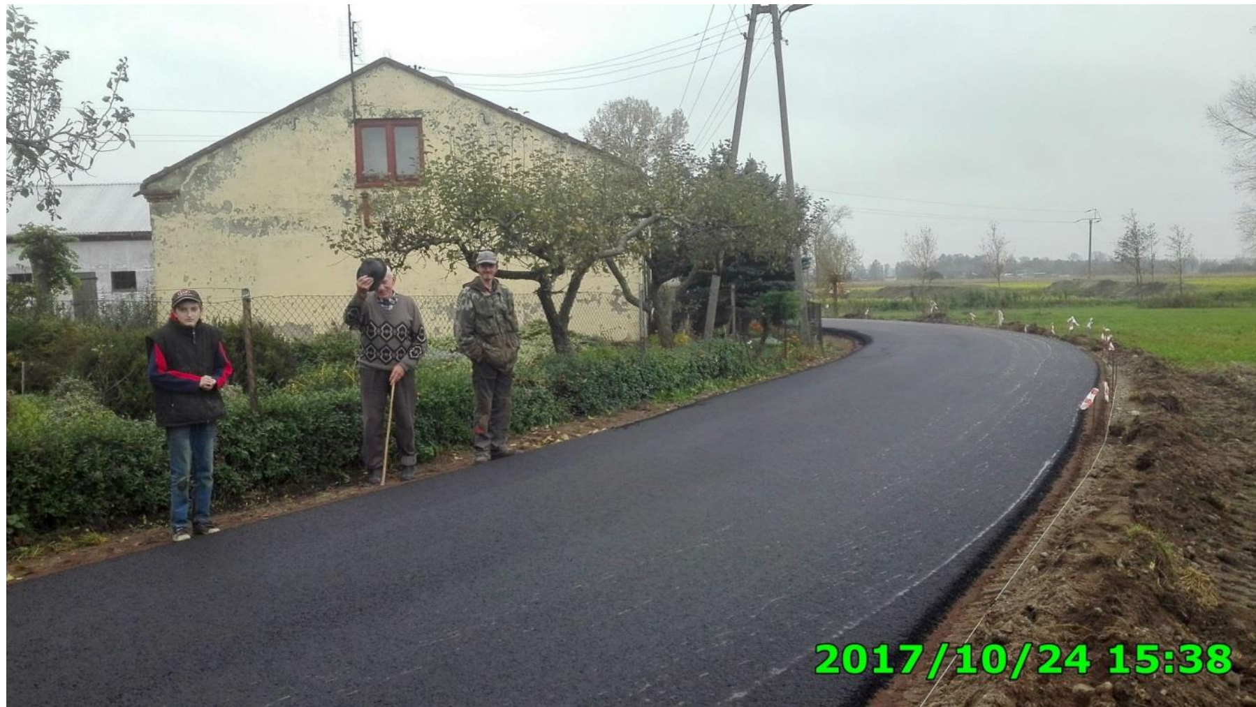
Przebudowa drogi gminnej w Zabłociu
