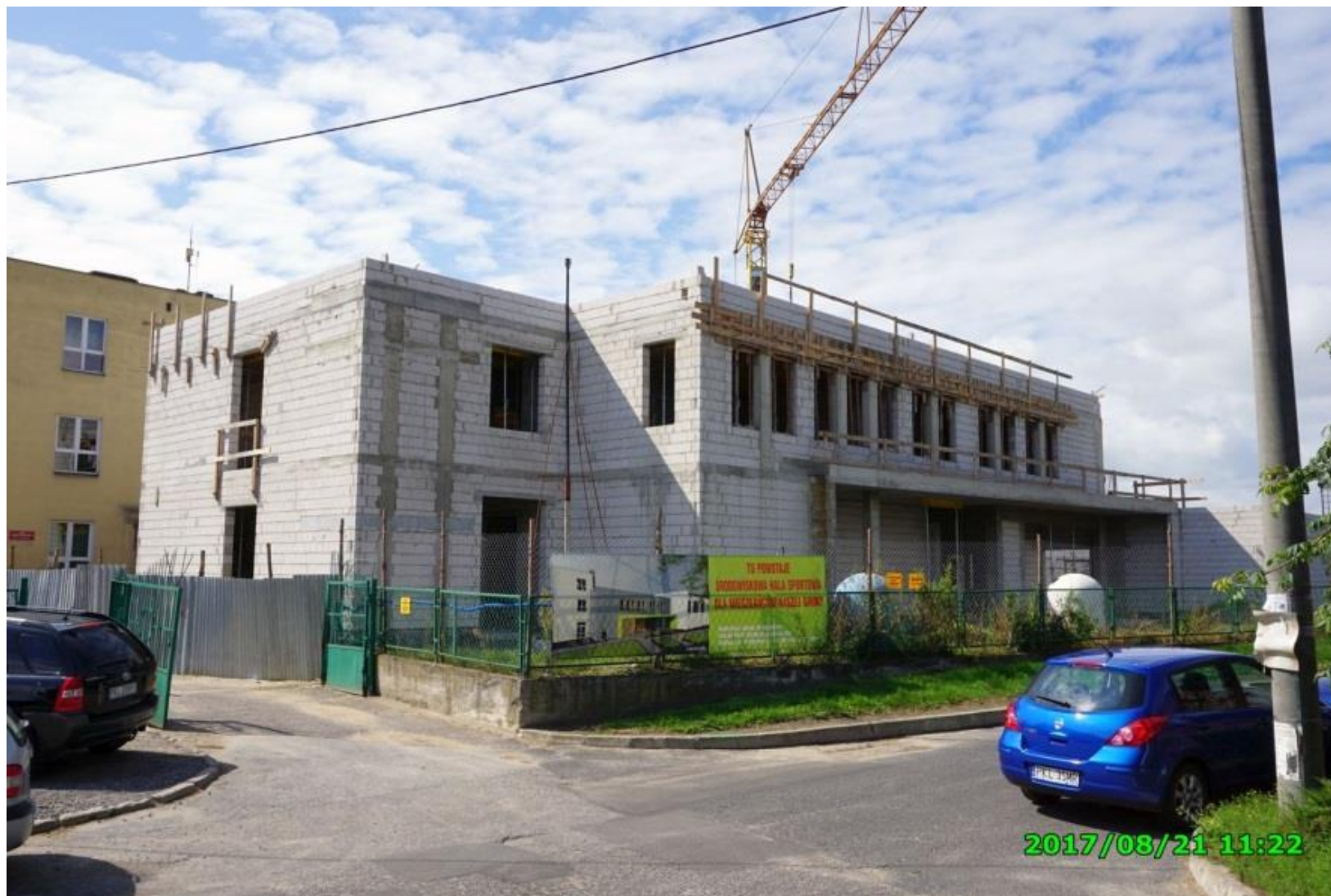
Budowa Środowiskowej Hali Sportowej w Grzegorzewie
