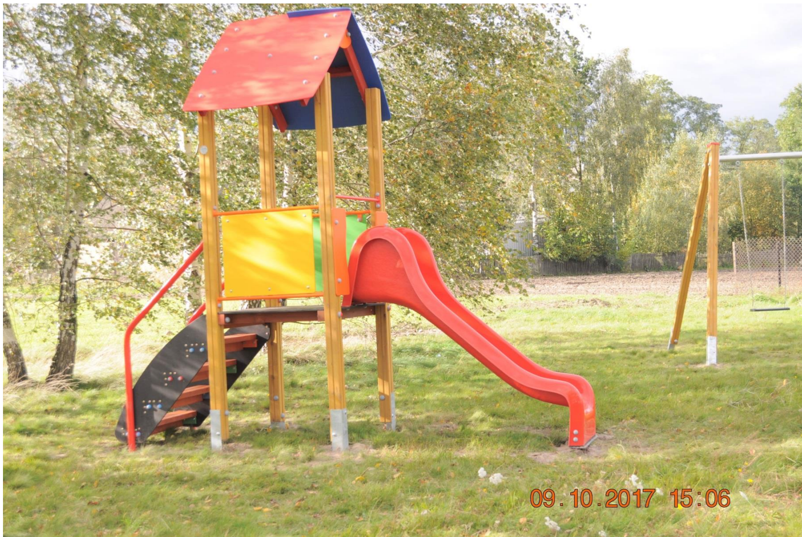
Wykonanie placu zabaw w Boguszyńcu
