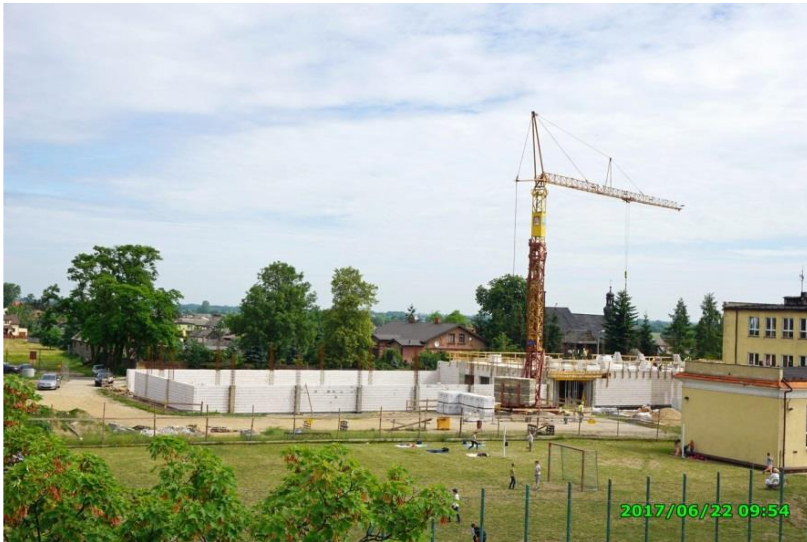
Budowa Środowiskowej Hali Sportowej w Grzegorzewie
