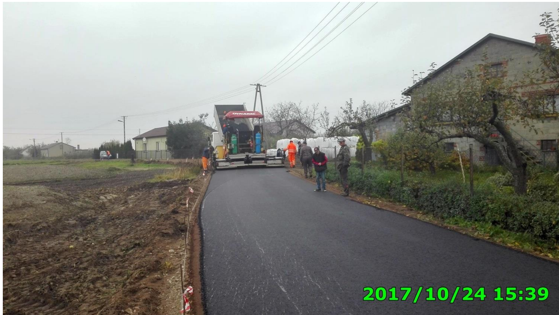
Przebudowa drogi gminnej w Zabłociu
