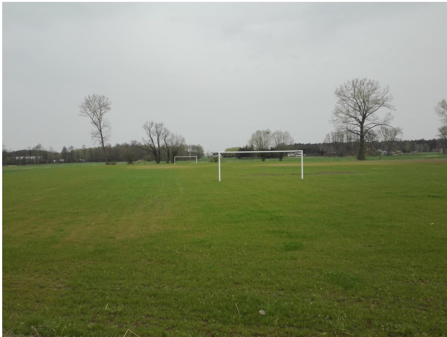
Budowa boiska w Borysławicach Kościelnych
