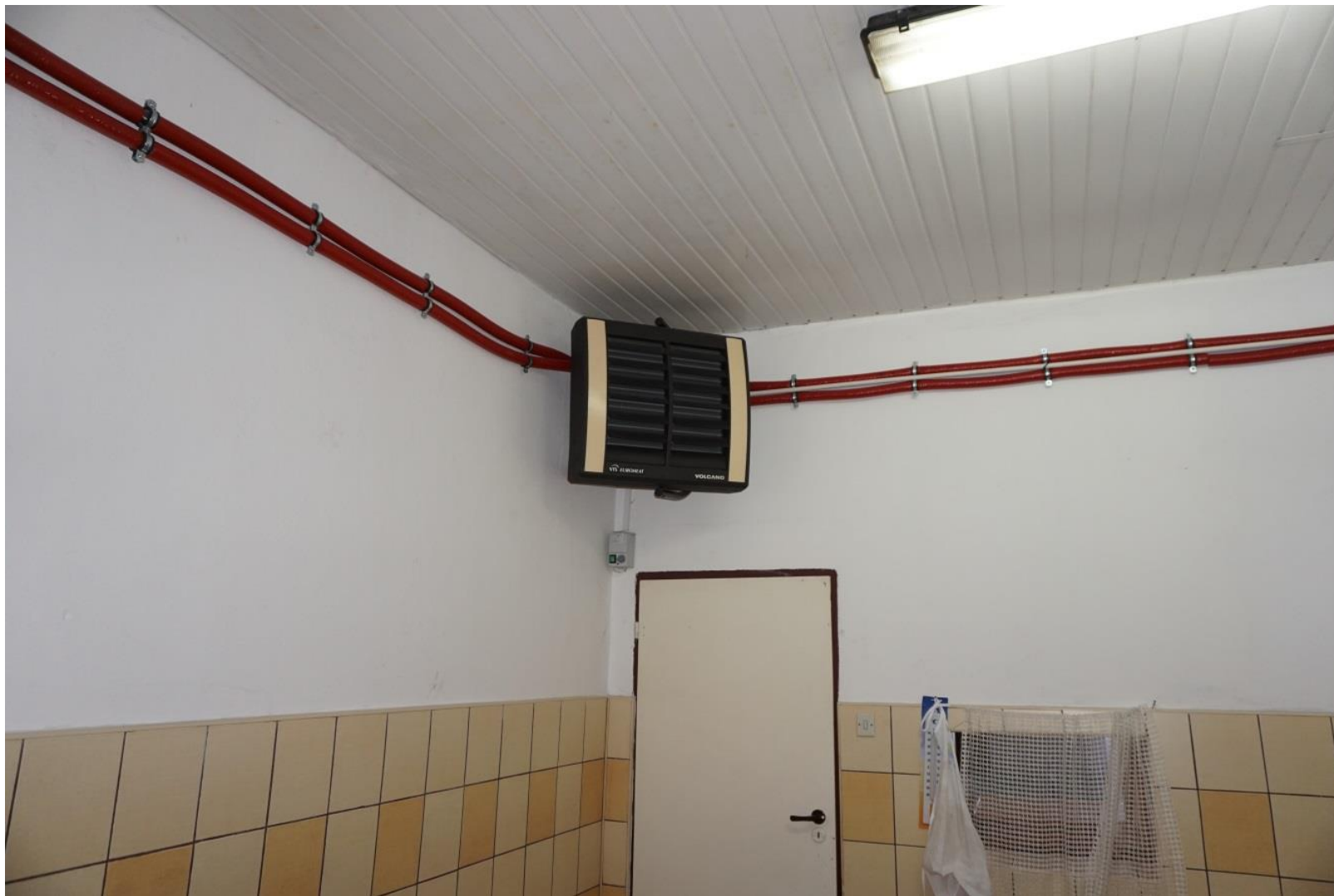
Wykonanie ogrzewania w Remizie OSP w Bylicach
