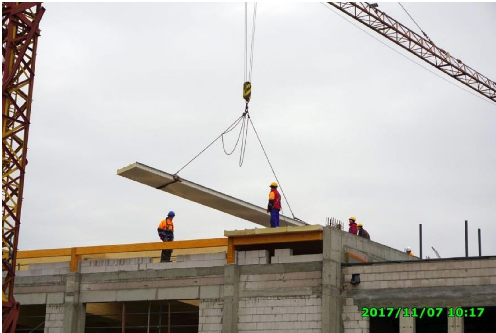
Budowa Środowiskowej Hali Sportowej w Grzegorzewie
