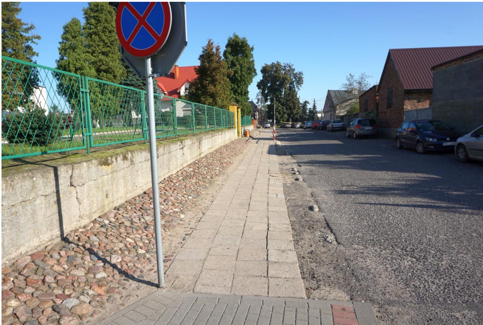
Budowa chodnika przy ulicy Szkolnej w Grzegorzewie
