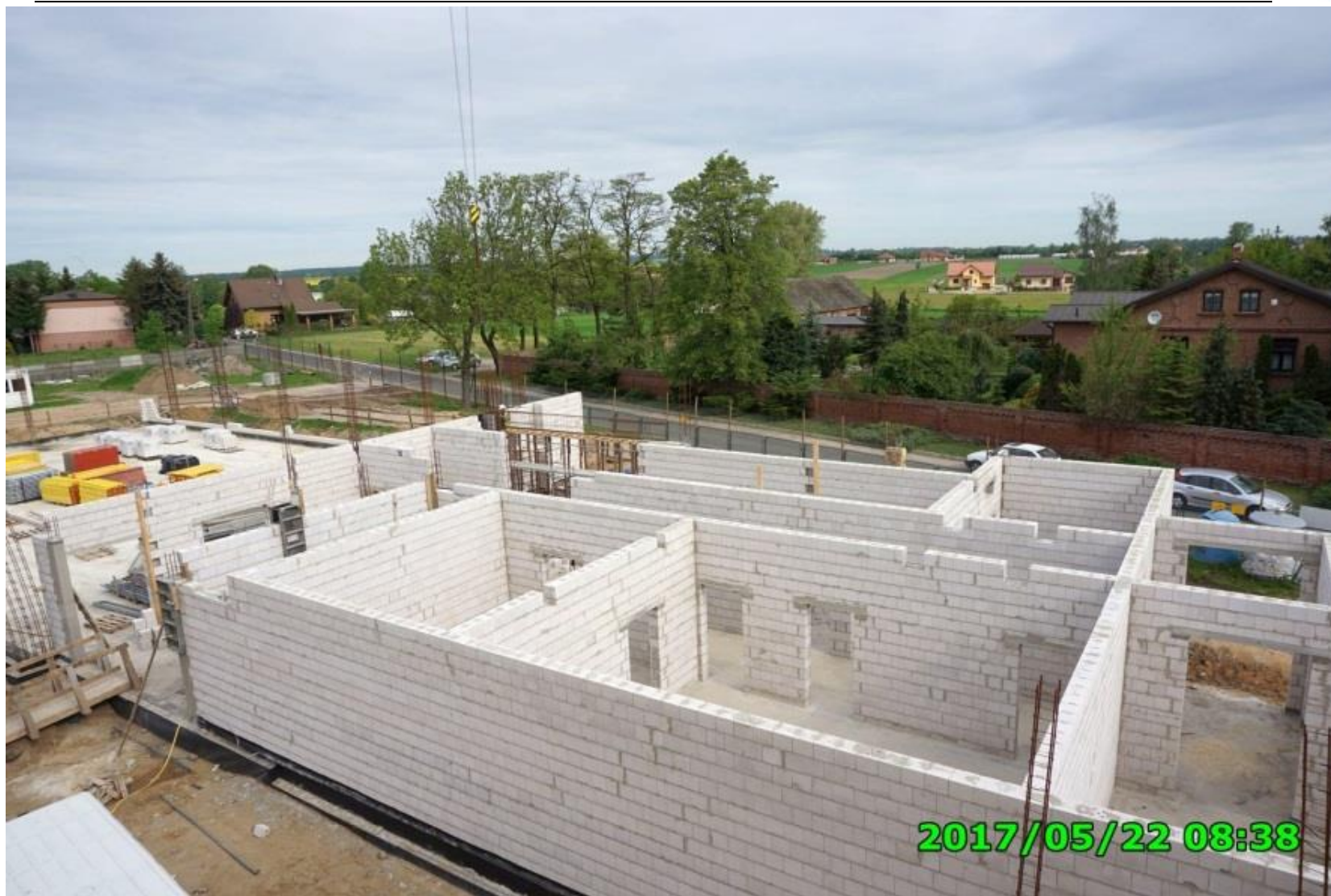
Budowa Środowiskowej Hali Sportowej w Grzegorzewie
