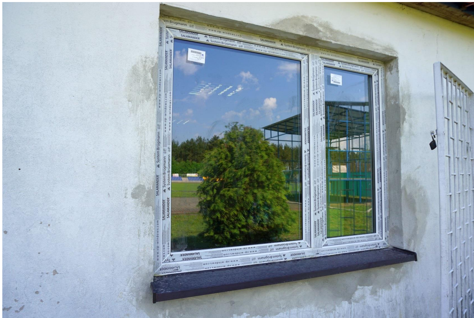
Wymiana okien w budynku na stadionie Gminnym w Grzegorzewie
