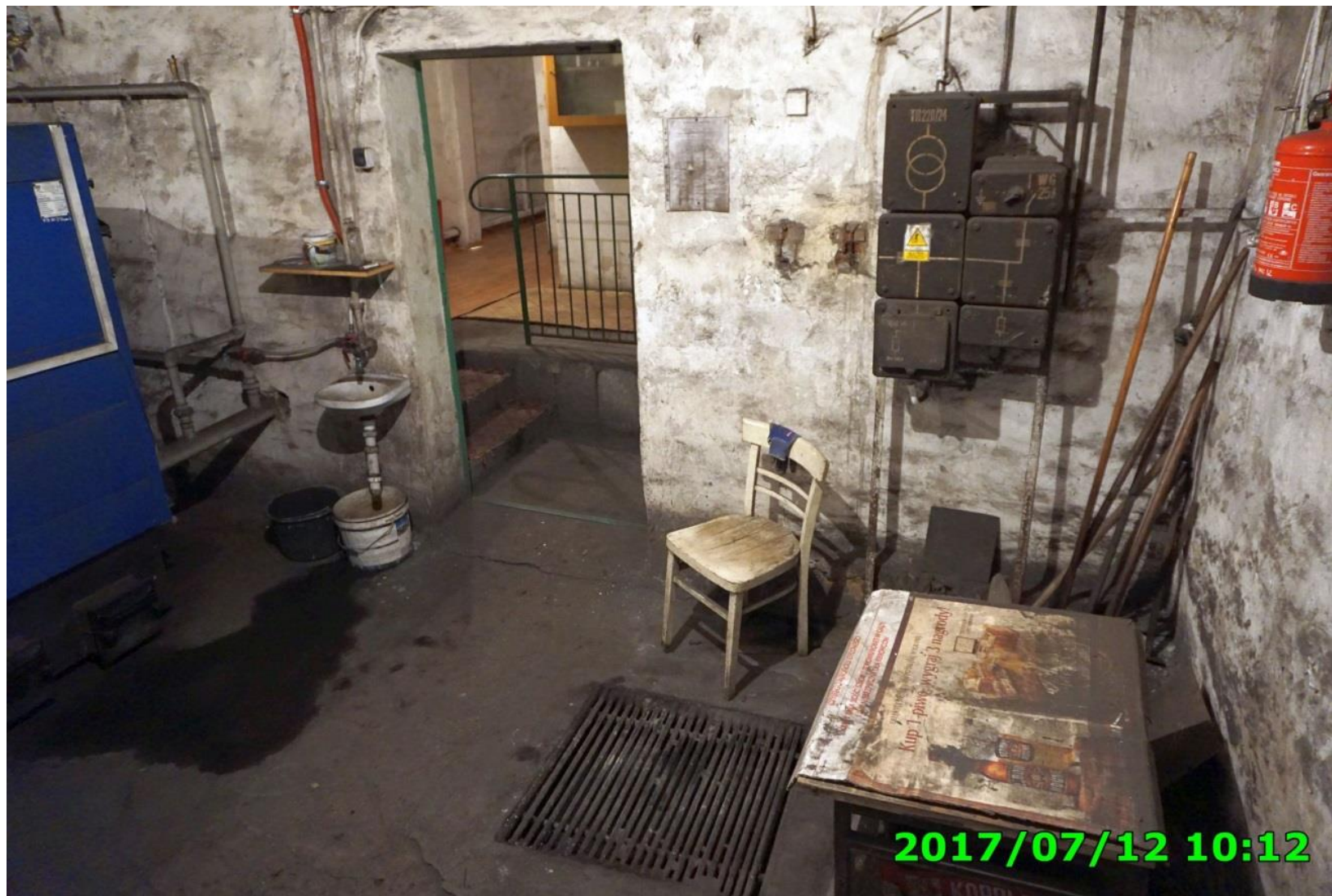
Przebudowa Kotłowni w Zespole Szkolno-Przedszkolnym w Grzegorzewie
