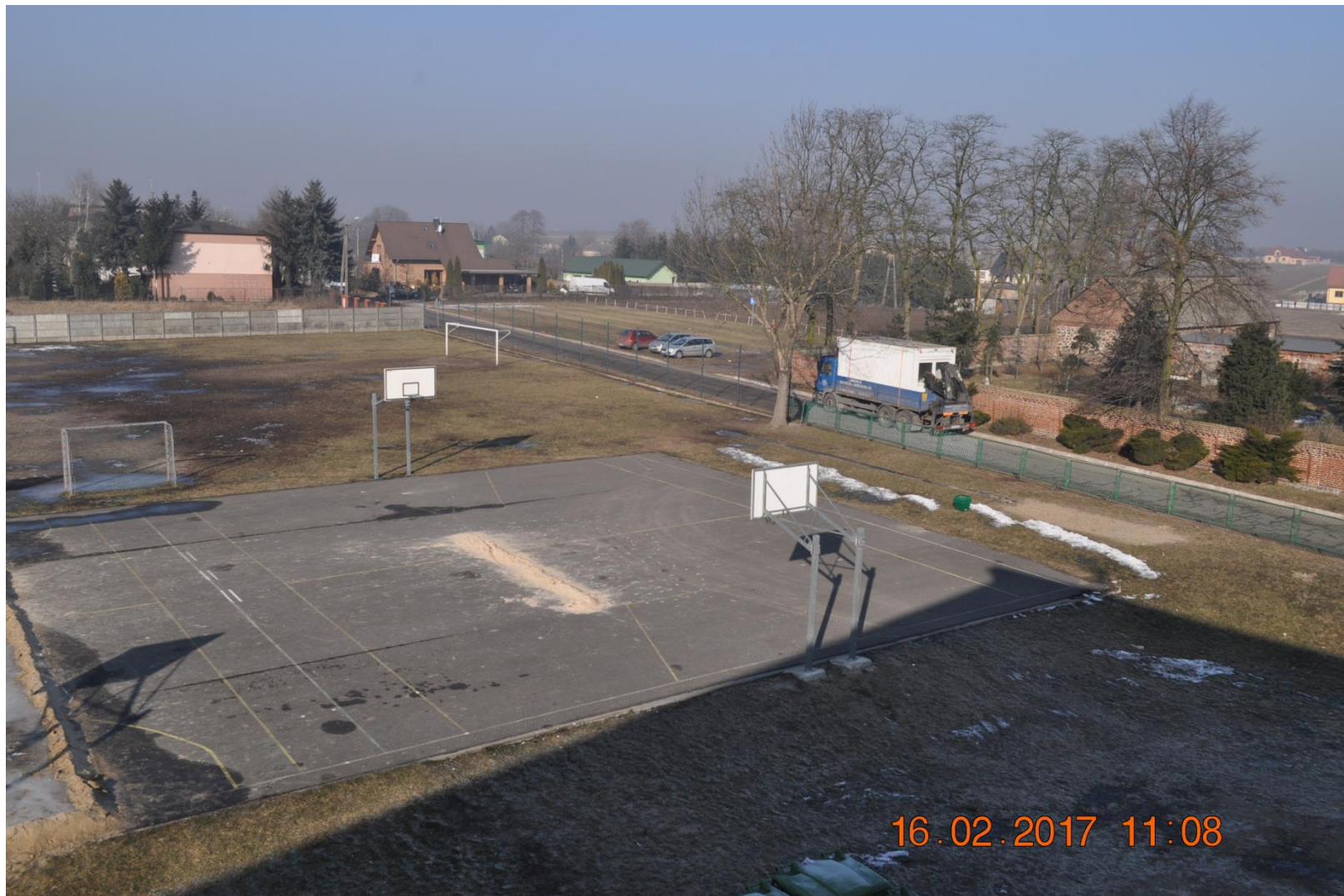
Budowa Środowiskowej Hali Sportowej w Grzegorzewie
