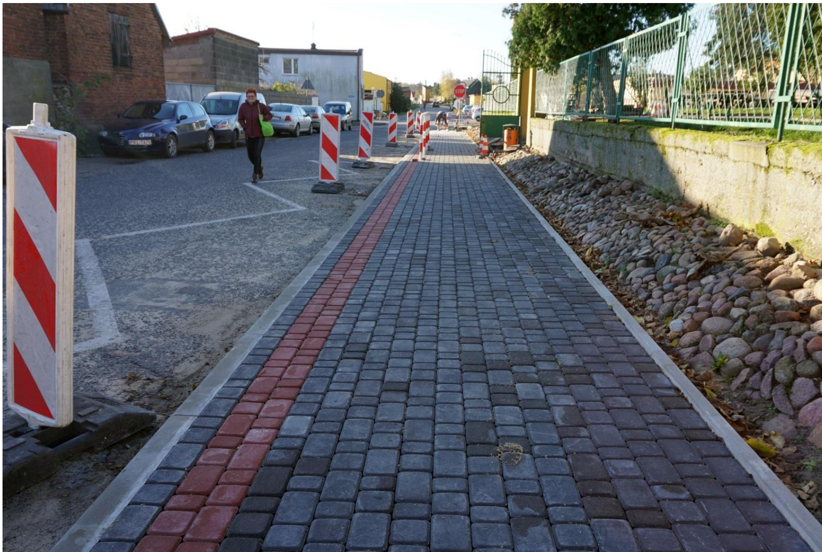
Budowa chodnika przy ulicy Szkolnej w Grzegorzewie
