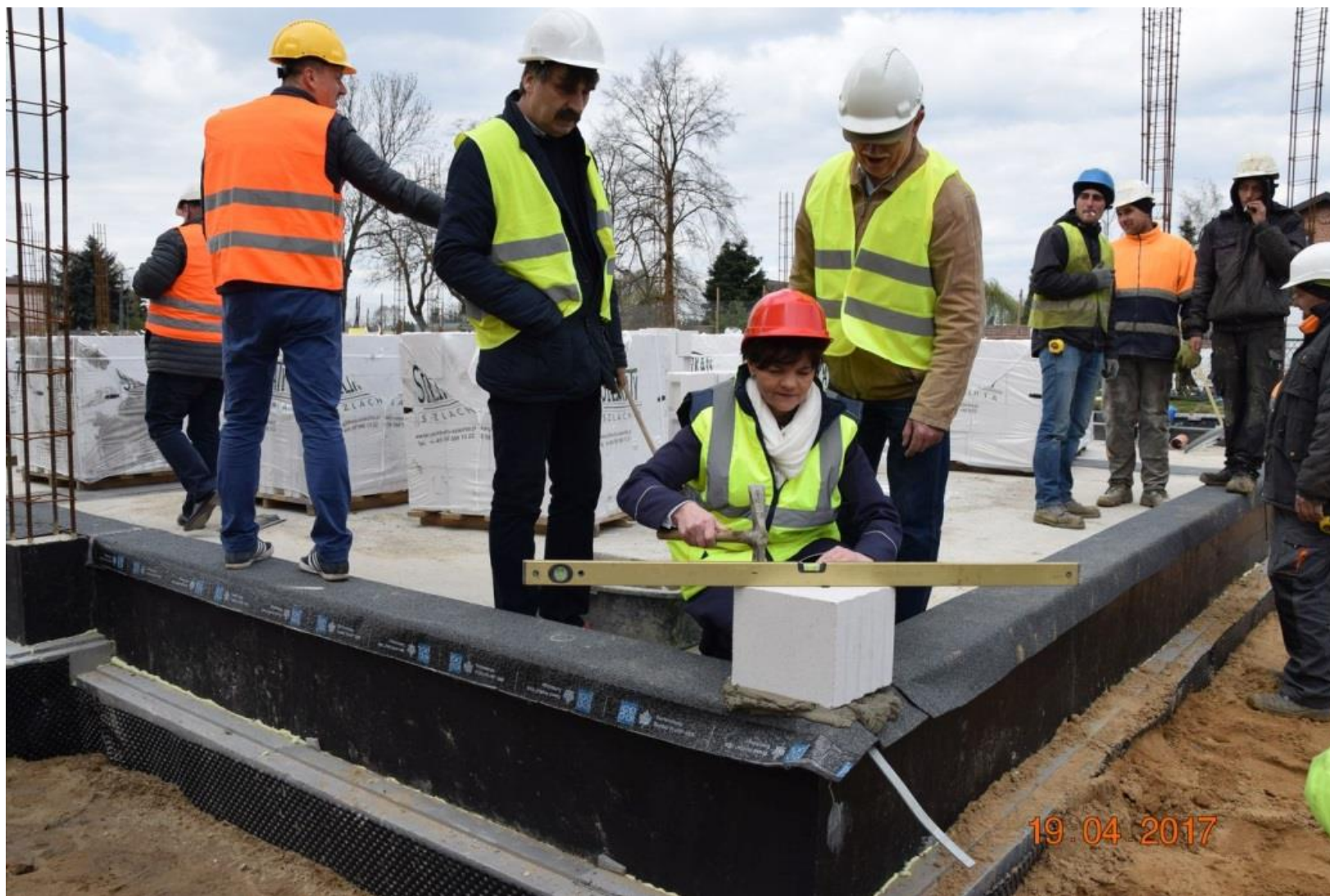
Budowa Środowiskowej Hali Sportowej w Grzegorzewie
