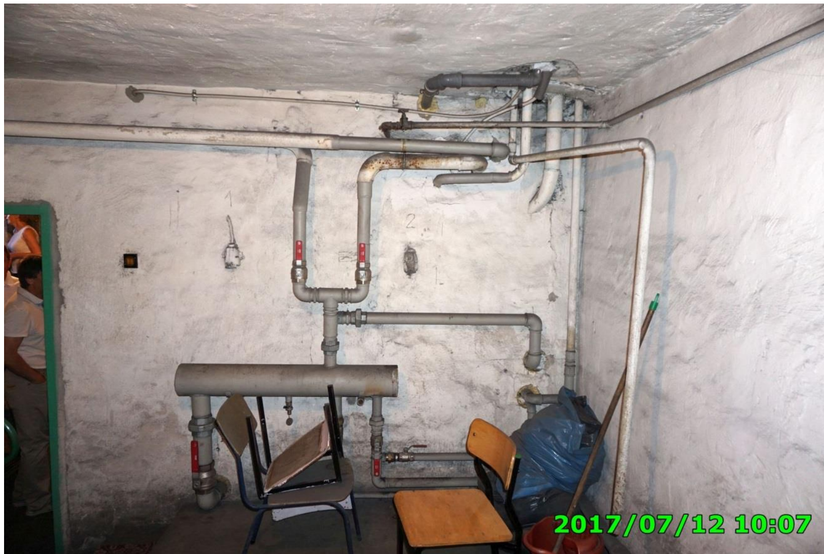
Przebudowa Kotłowni w Zespole Szkolno-Przedszkolnym w Grzegorzewie
