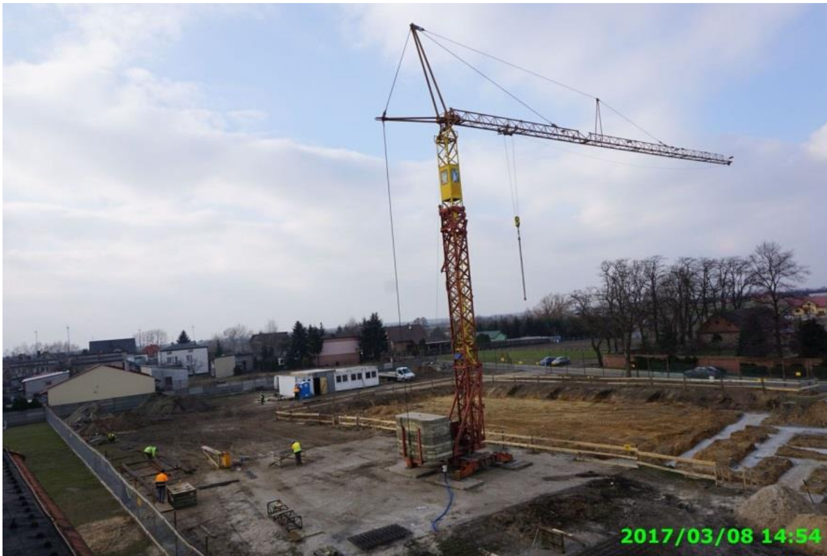
Budowa Środowiskowej Hali Sportowej w Grzegorzewie
