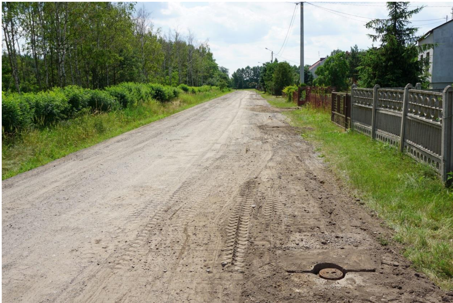
Przebudowa ulicy Piaski w Grzegorzewie
