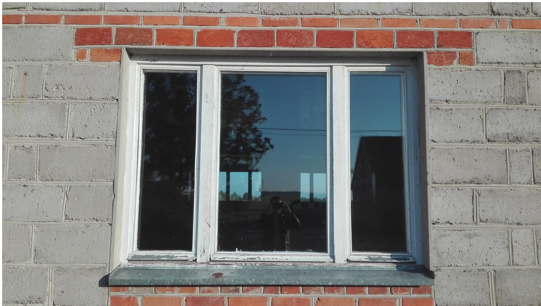
Wymiana okien w Świetlicy Wiejskiej w Ladorudzku
