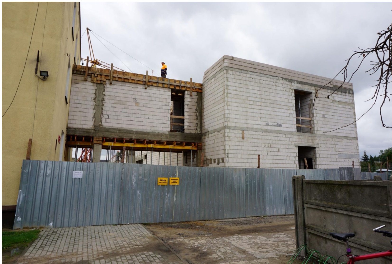
Budowa Środowiskowej Hali Sportowej w Grzegorzewie
