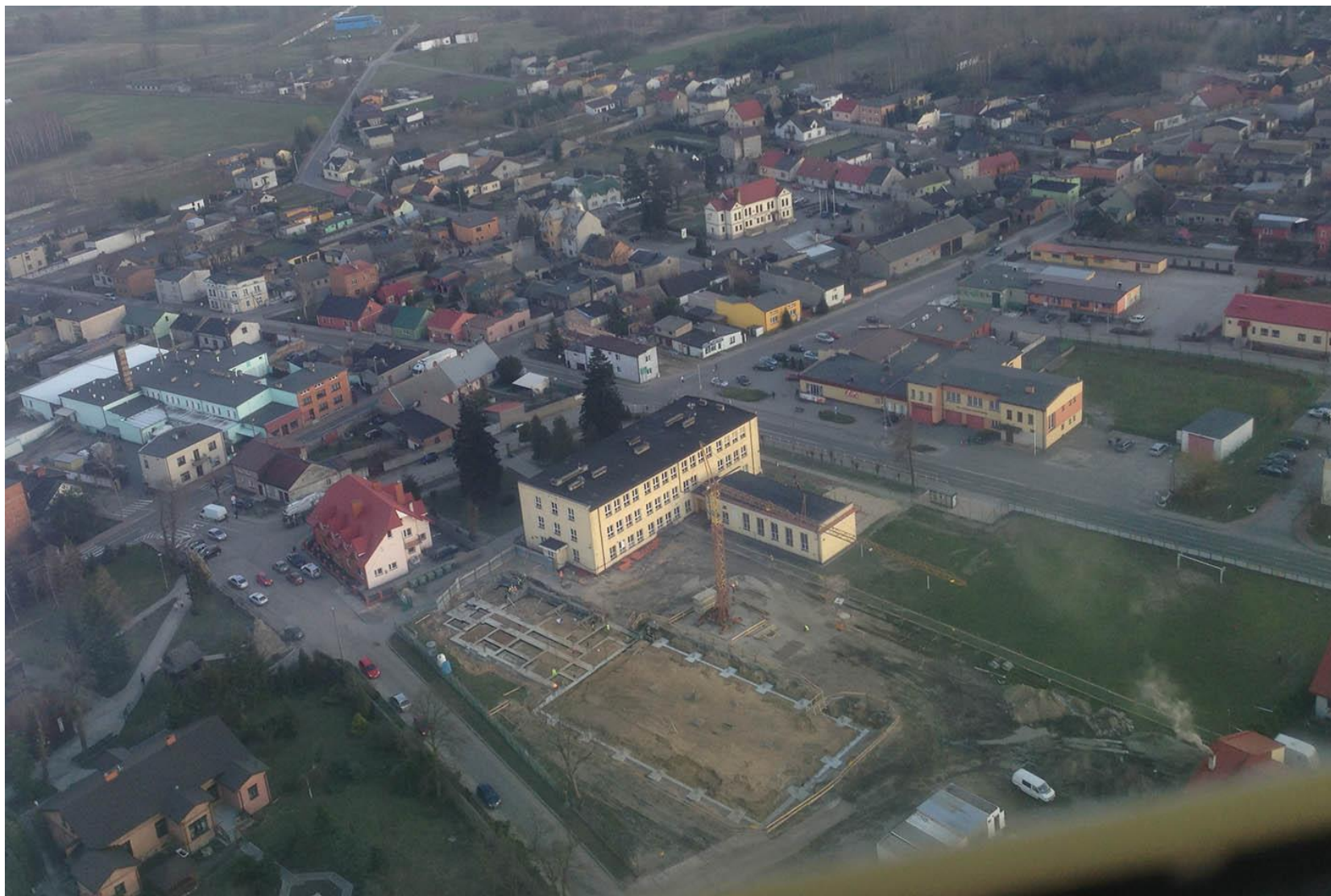
Budowa Środowiskowej Hali Sportowej w Grzegorzewie
