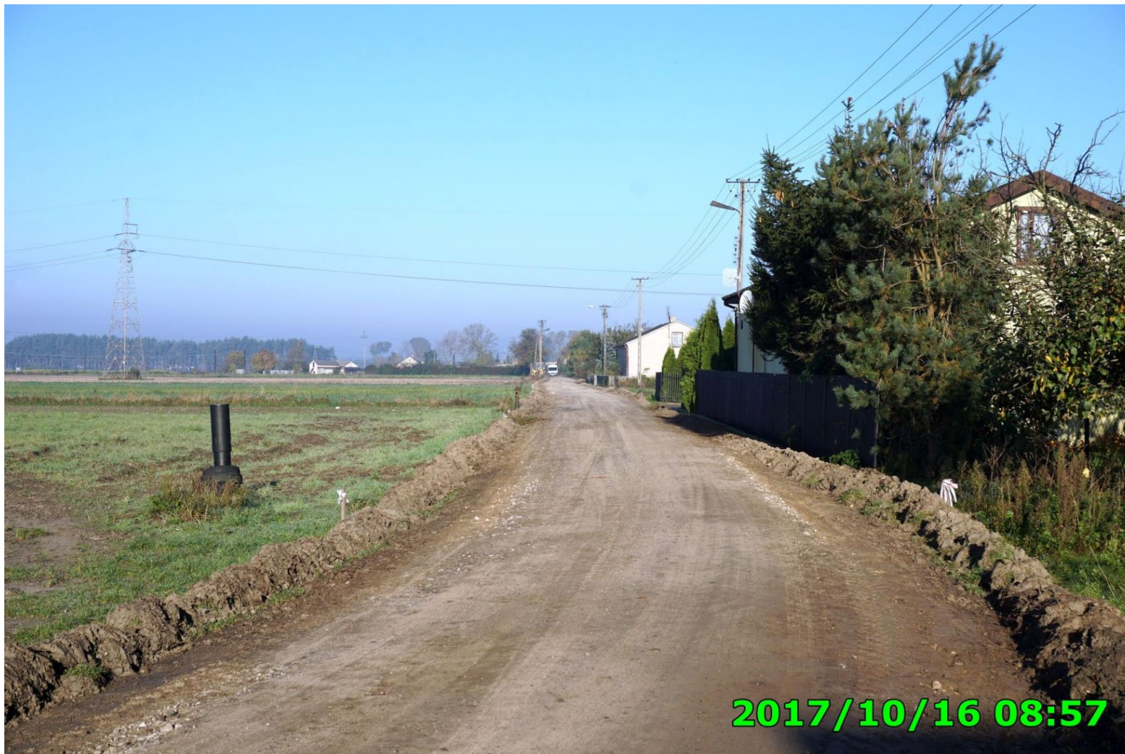
Przebudowa drogi gminnej w Zabłociu
