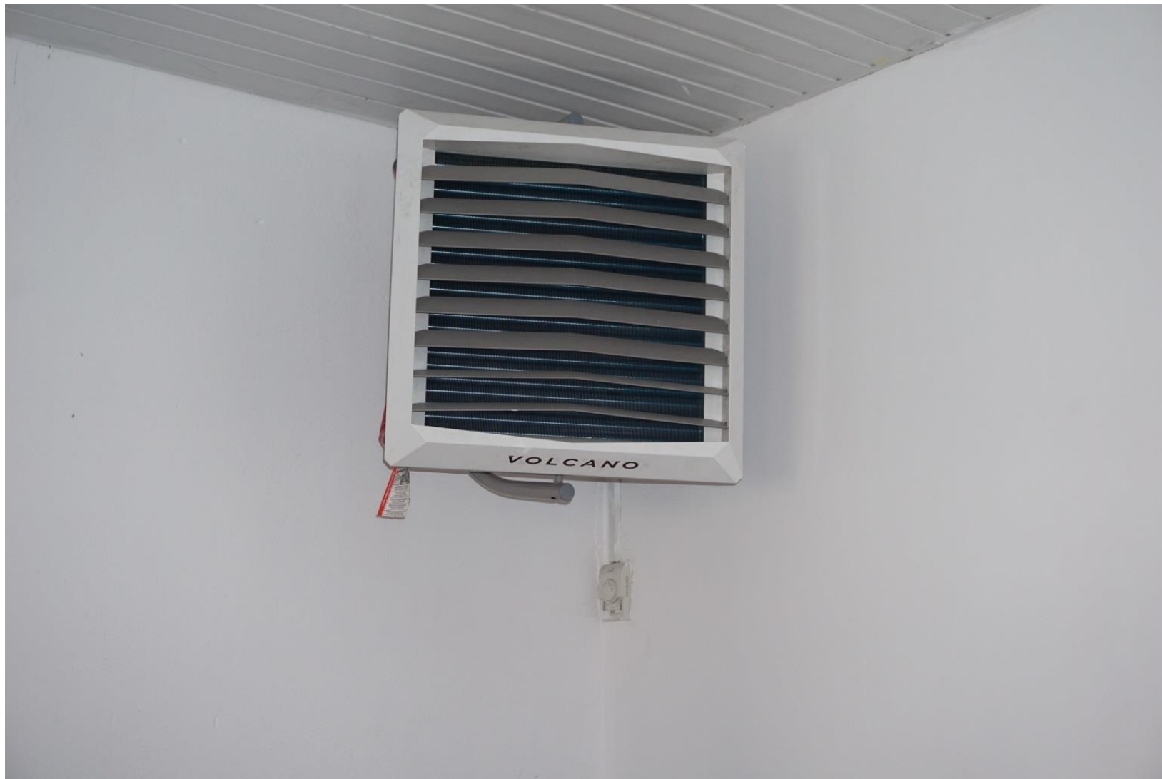
Wykonanie ogrzewania w Remizie OSP w Bylicach
