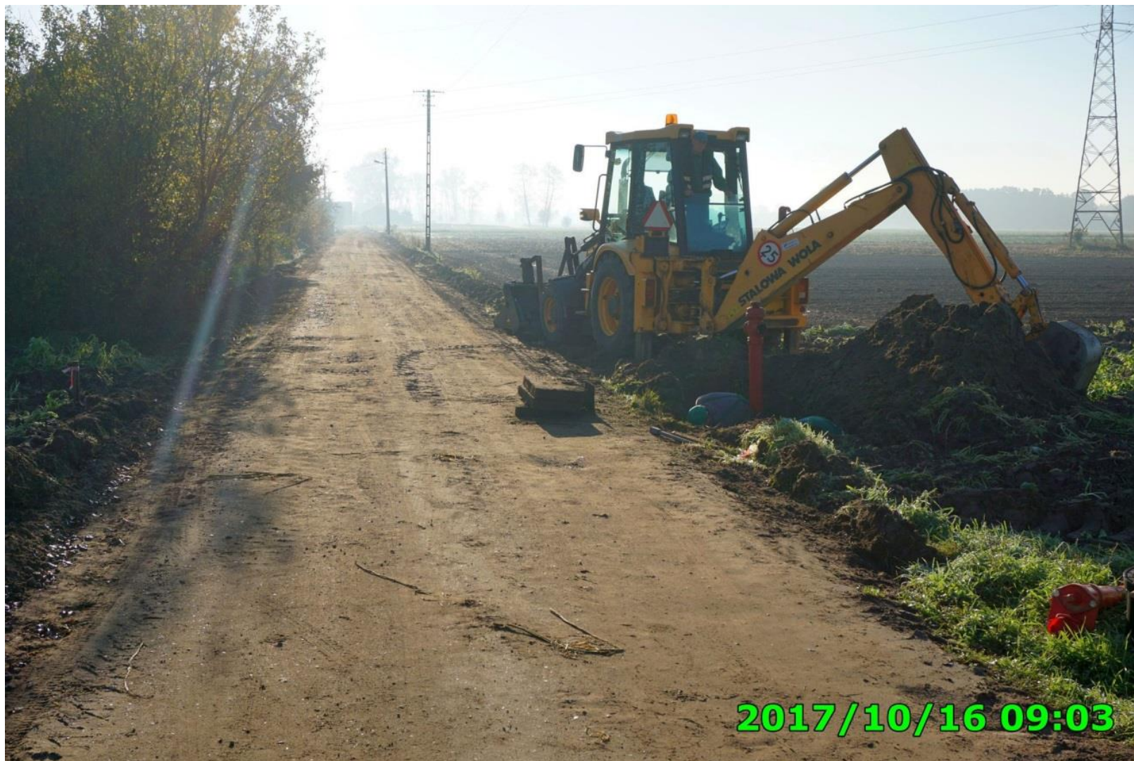
Przebudowa drogi gminnej w Zabłociu
