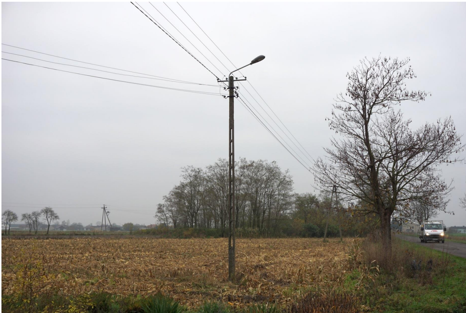
Montaż oświetlenia ulicznego w Tarnówce
