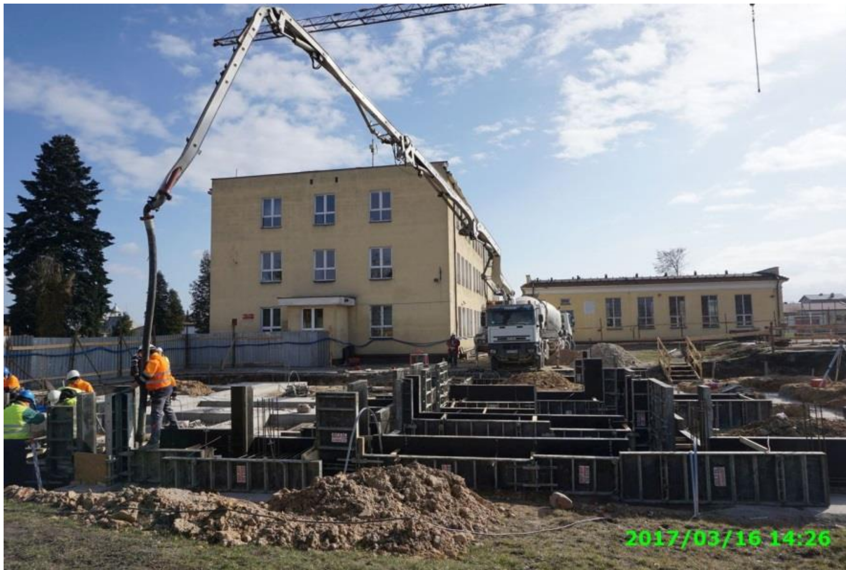
Budowa Środowiskowej Hali Sportowej w Grzegorzewie
