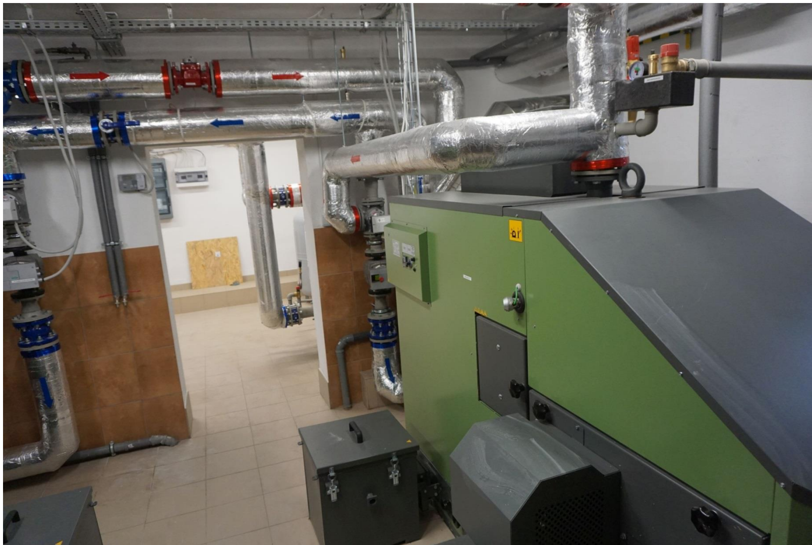
Przebudowa Kotłowni w Zespole Szkolno-Przedszkolnym w Grzegorzewie
