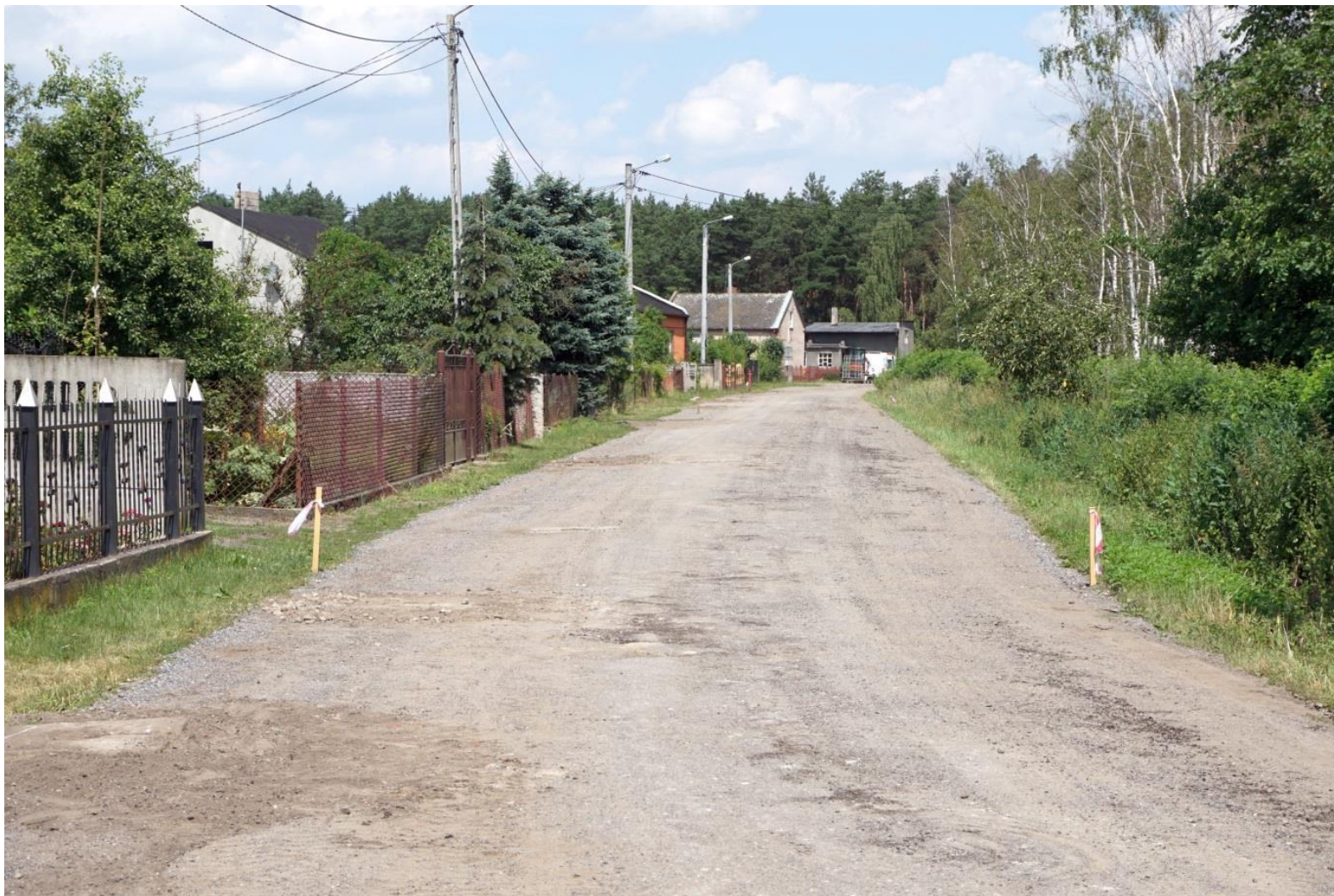
Przebudowa ulicy Piaski w Grzegorzewie
