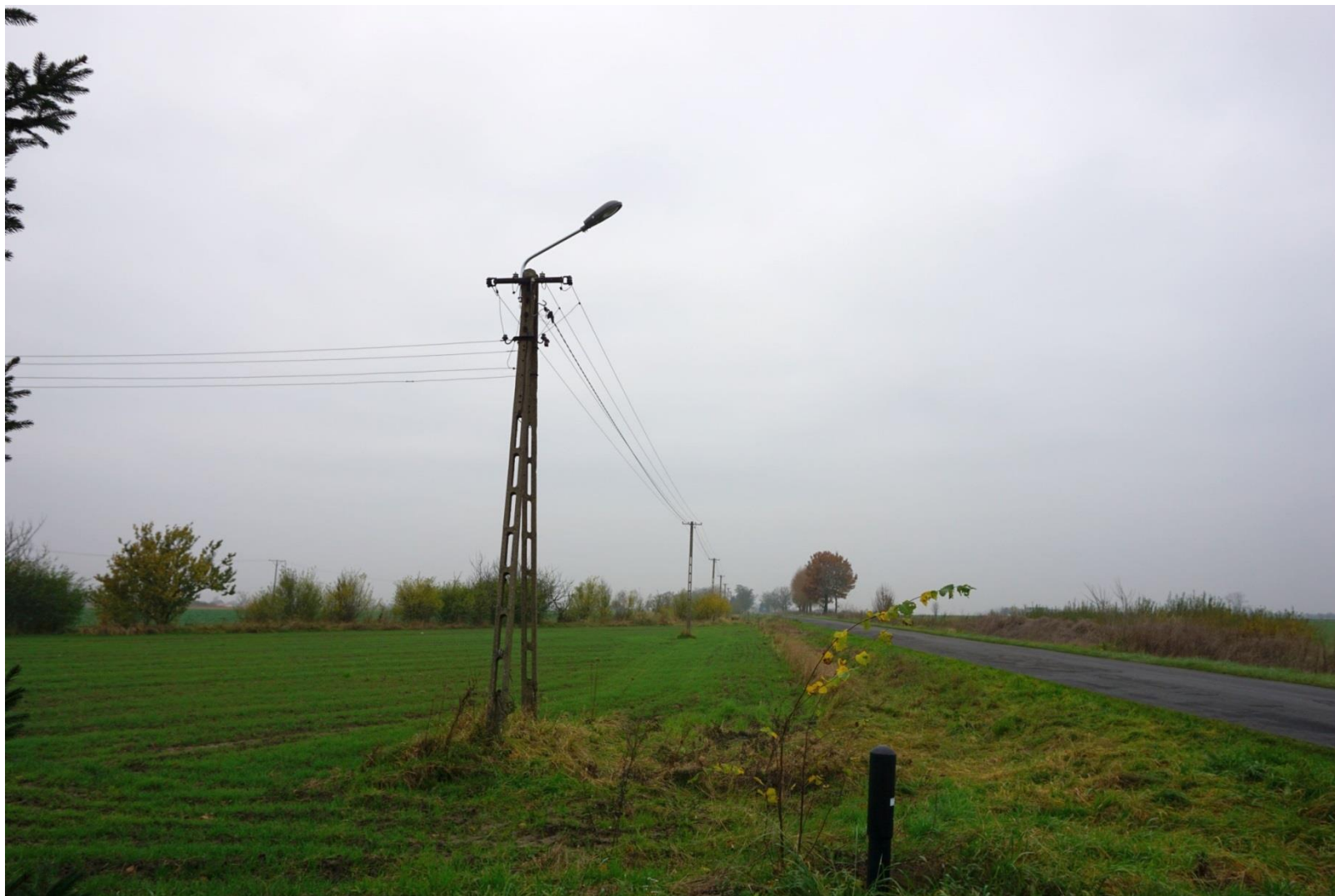
Montaż oświetlenia ulicznego w Tarnobrzegu
