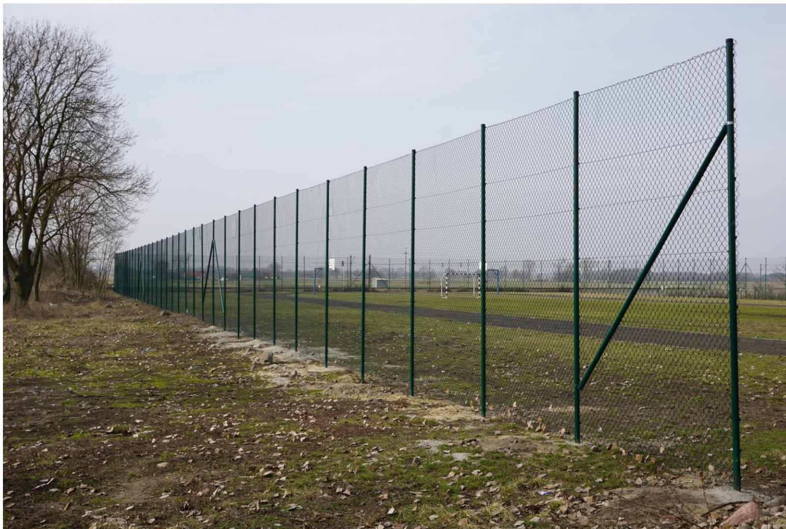
Wykonanie ogrodzenia przy szkole podstawowej w Bylicach-Kolonii
