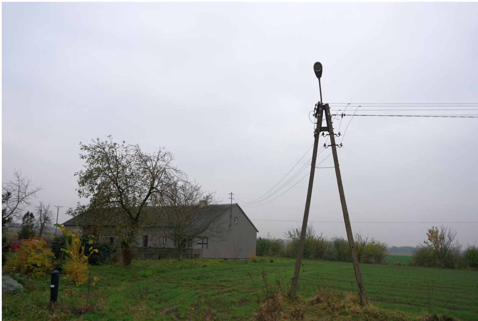
Montaż oświetlenia ulicznego w Tarnówce
