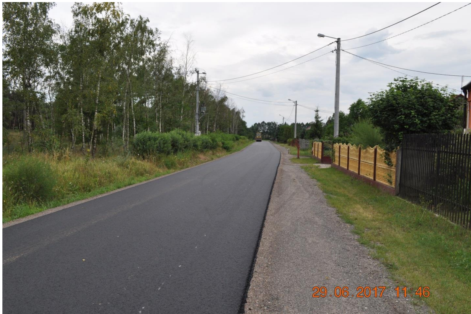
Przebudowa ulicy Piaski w Grzegorzewie
