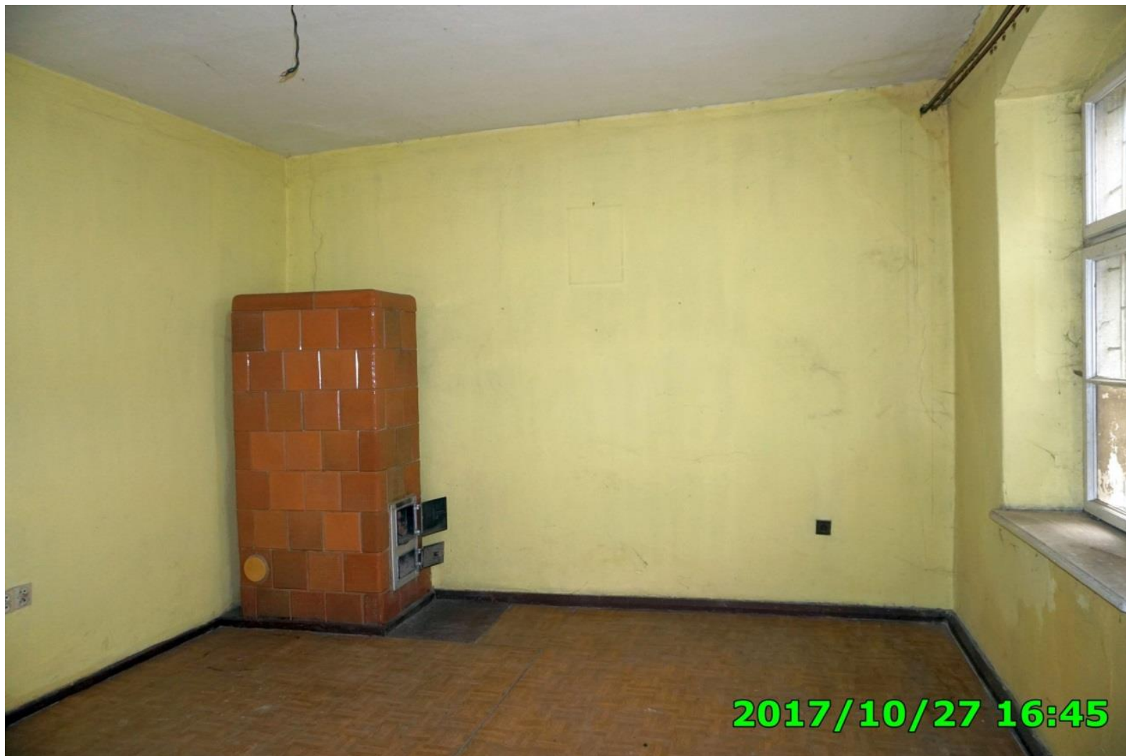
Remont budynku ul. Warszawska 23 - Klub "Senior +"
