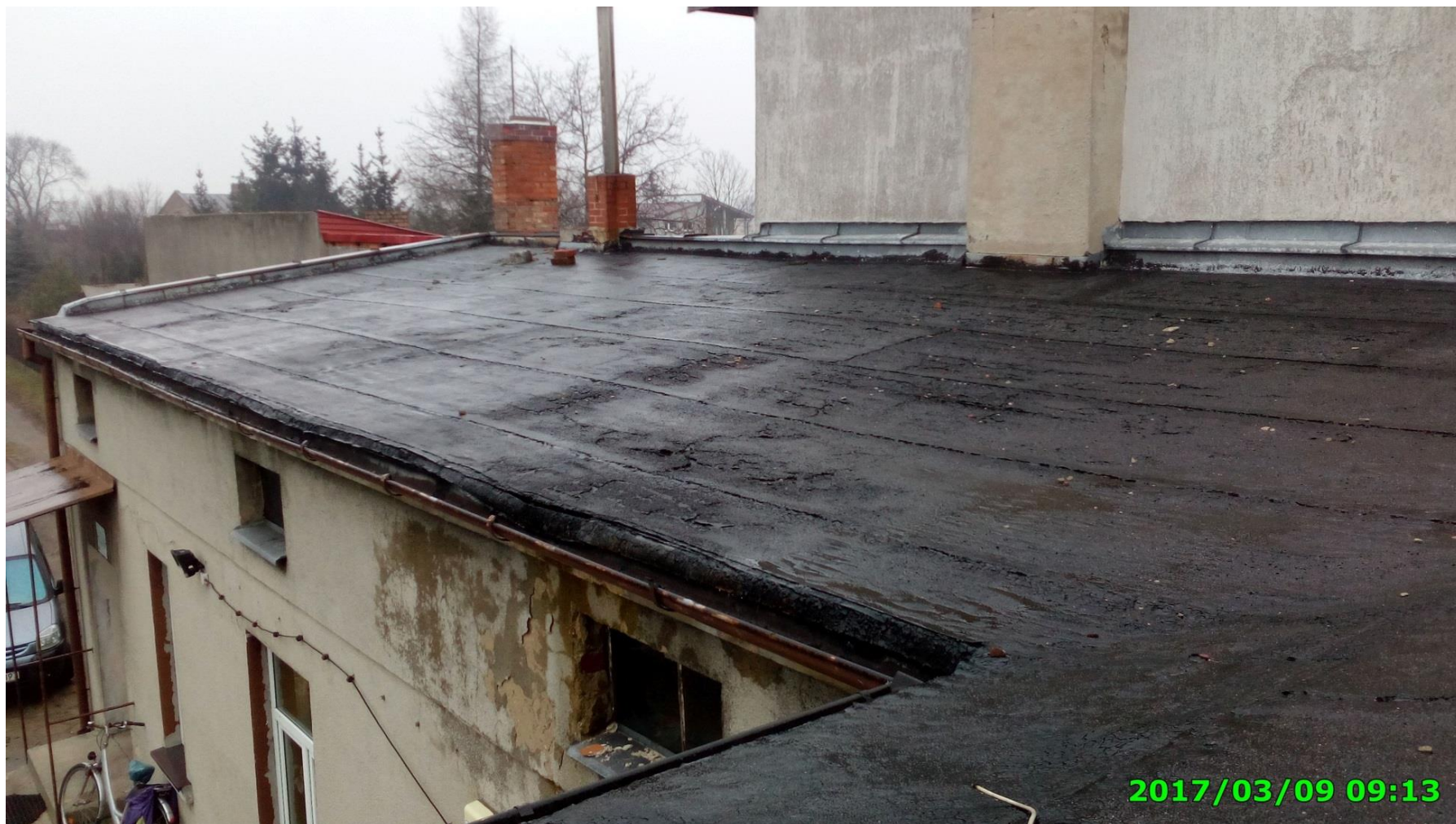
Remont budynku ul. Warszawska 23 - Klub "Senior +"
