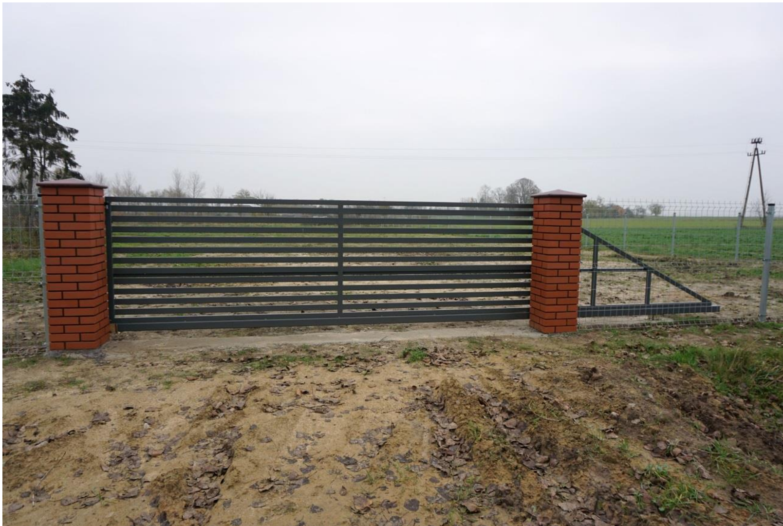
Wykonanie ogrodzenia przy świetlicy wiejskiej w Grodnej
