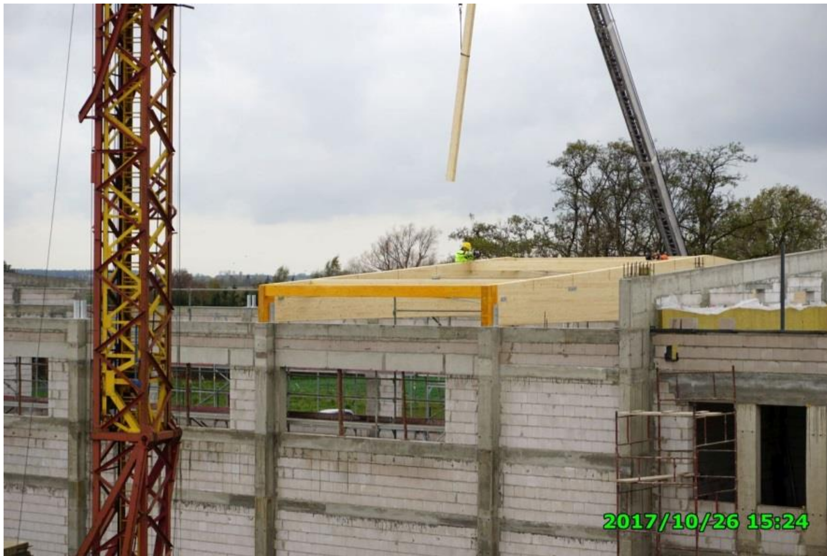
Budowa Środowiskowej Hali Sportowej w Grzegorzewie
