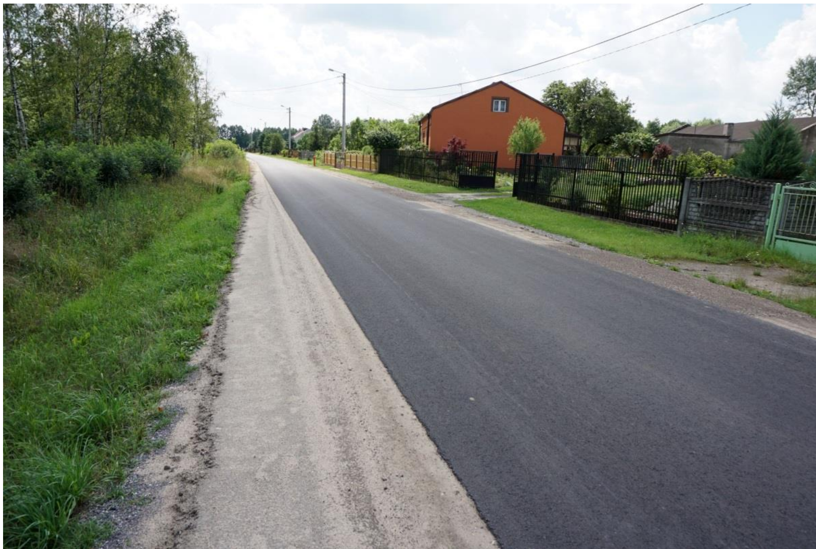
Przebudowa ulicy Piaski w Grzegorzewie
