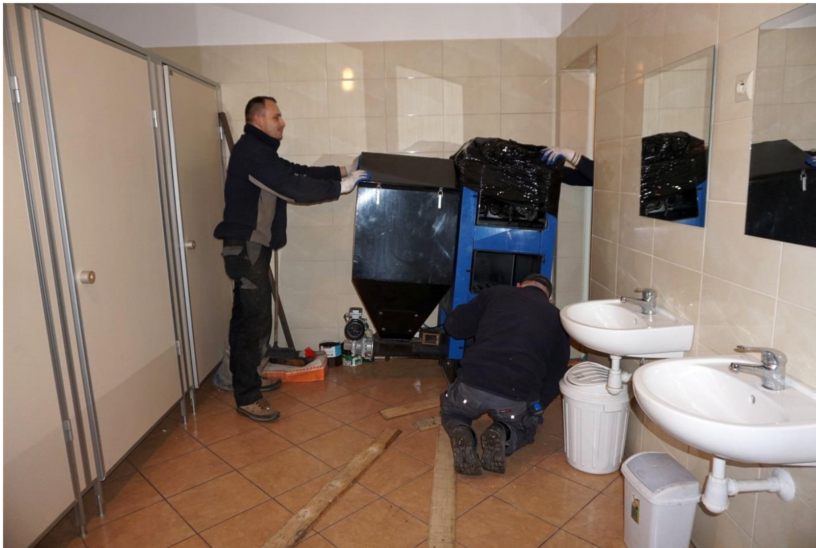
Montaż Ogrzewania w Remizie OSP w Ponętowie Dolnym
