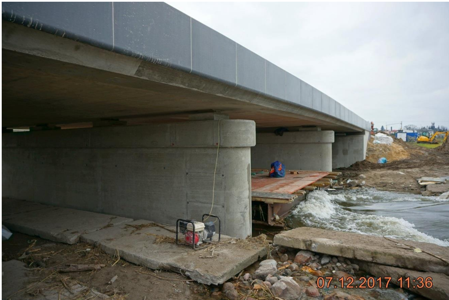
Przebudowa mostu na rzece Rgilewce w miejscowości Grzegorzew
