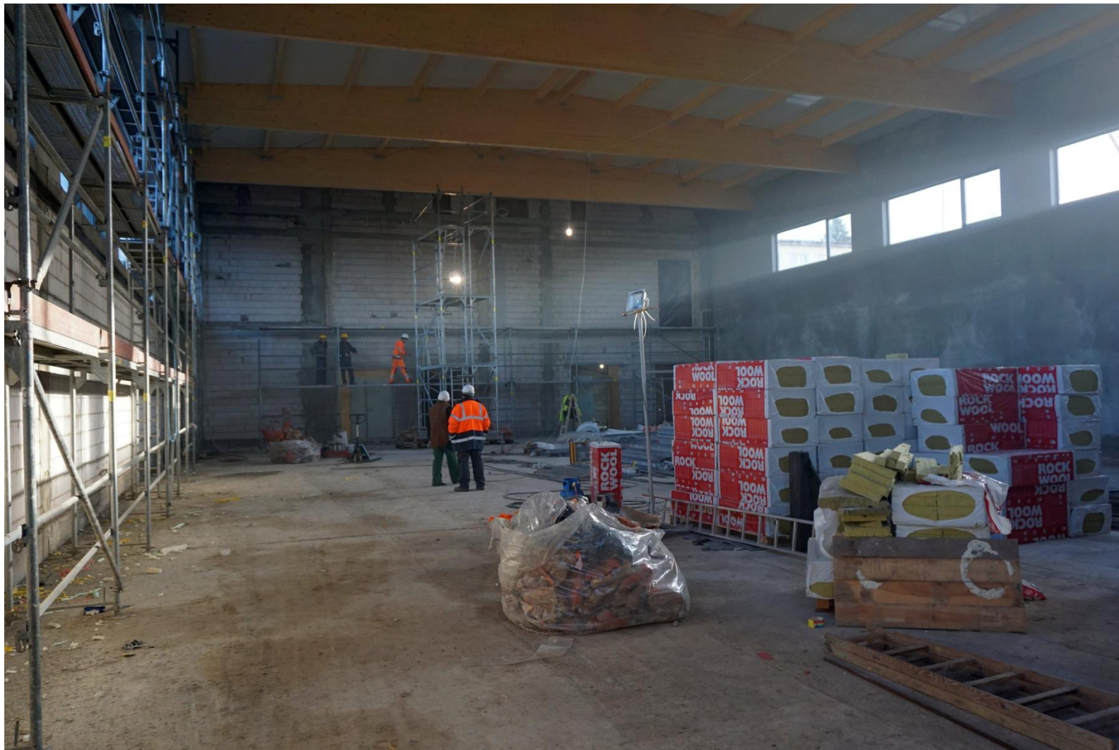
Budowa Środowiskowej Hali Sportowej w Grzegorzewie
