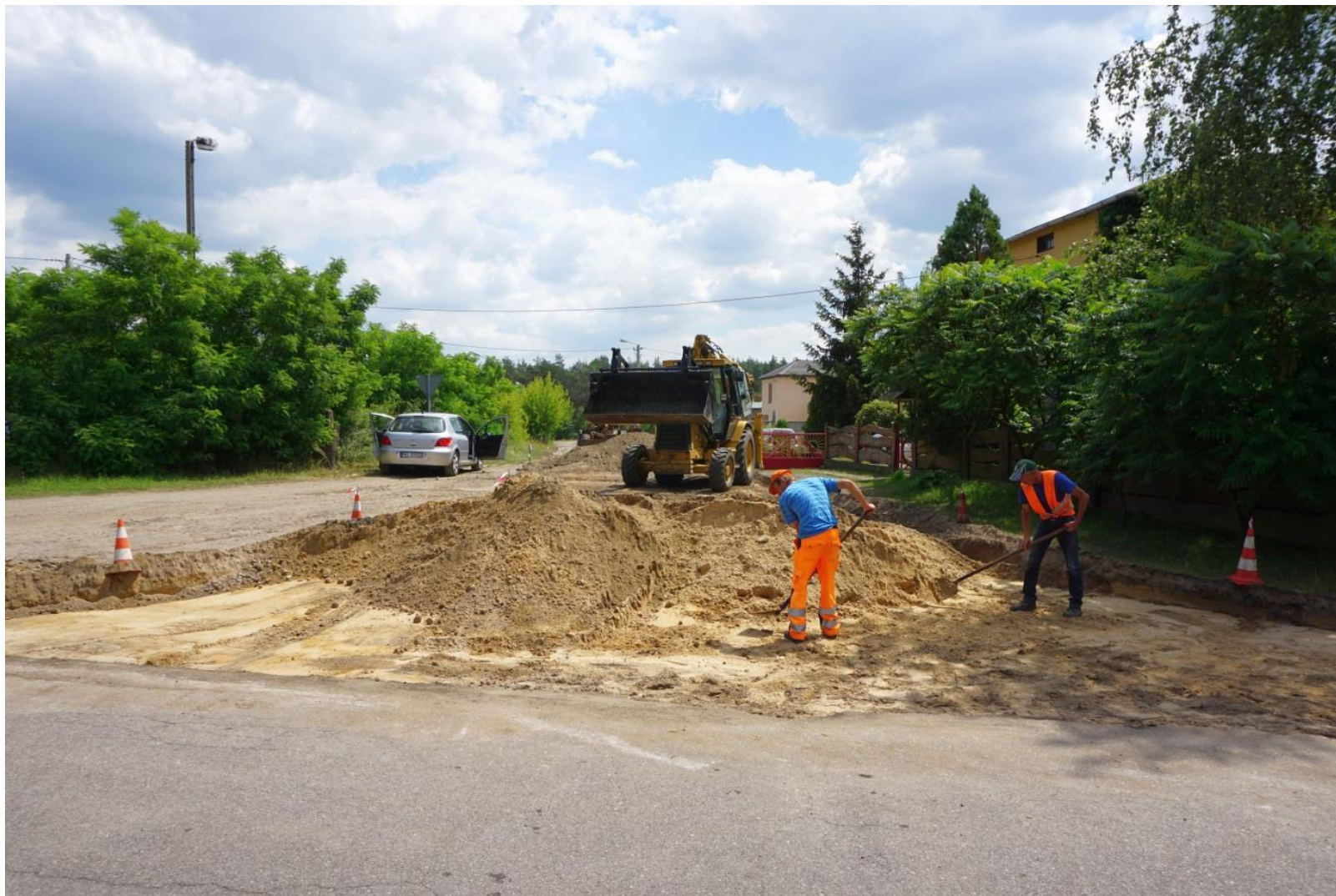
Przebudowa ulicy Piaski w Grzegorzewie
