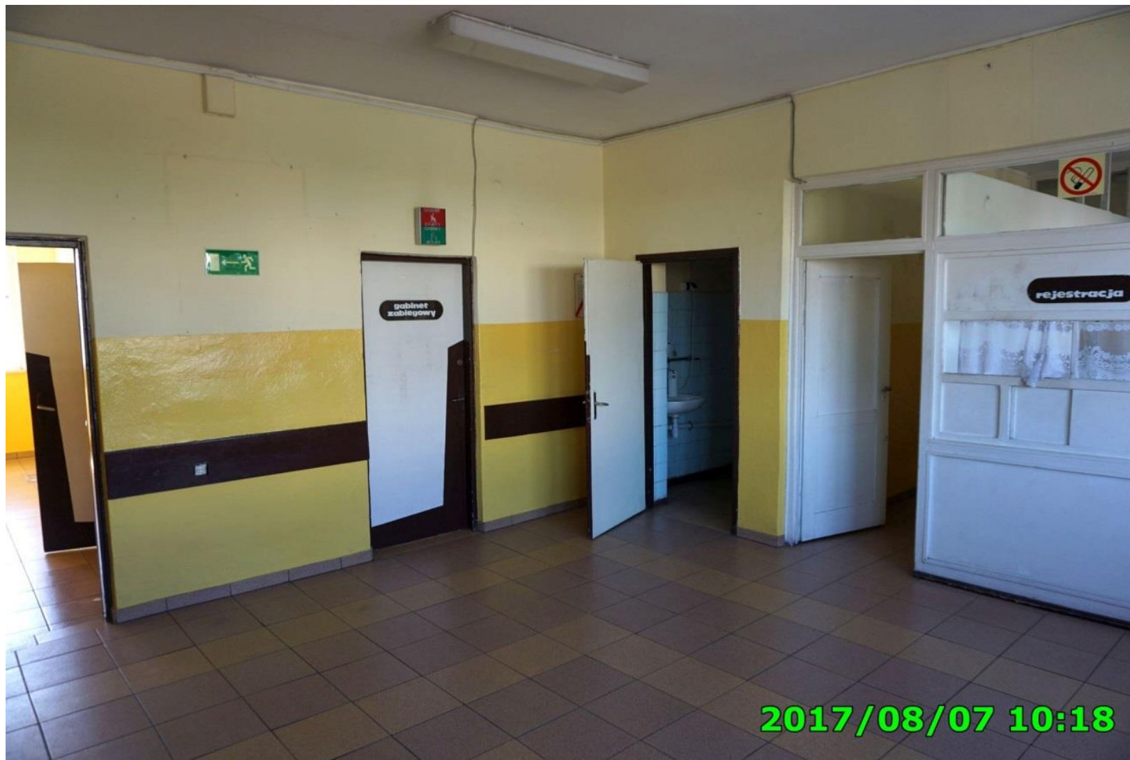
Remont ośrodka zdrowia w Grzegorzewie
