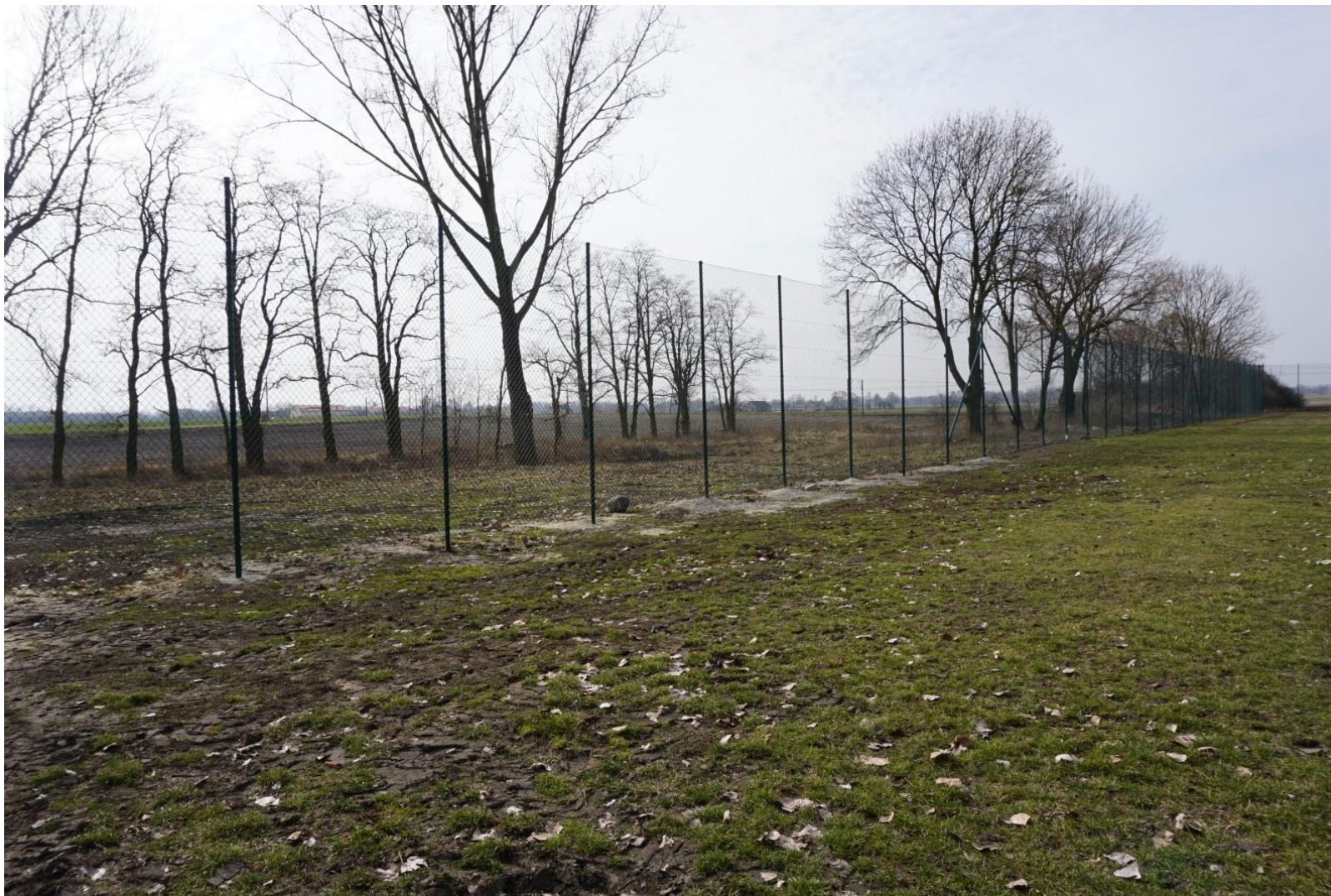
Wykonanie ogrodzenia przy szkole podstawowej w Bylicach-Kolonii
