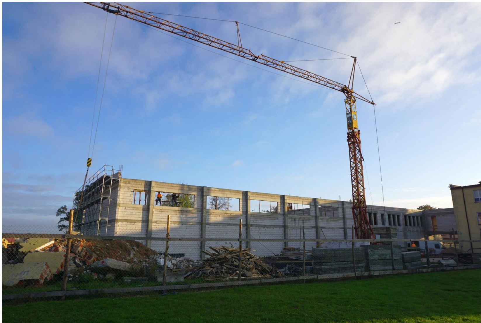
Budowa Środowiskowej Hali Sportowej w Grzegorzewie
