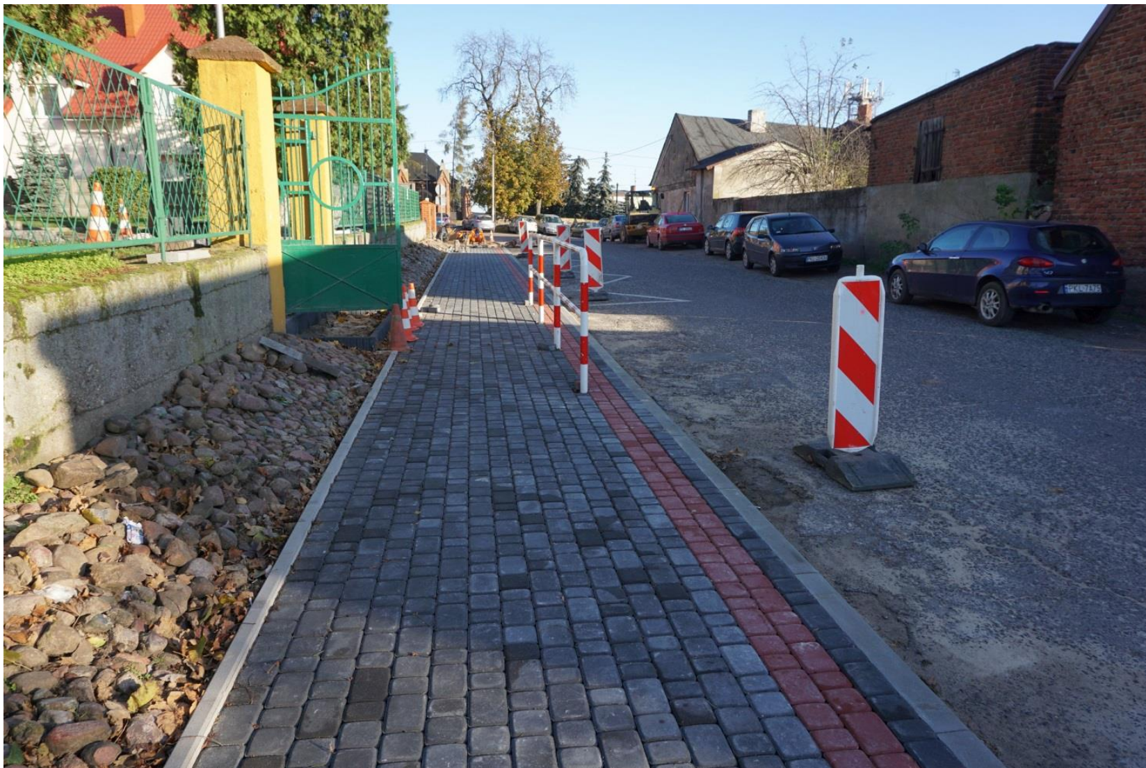
Budowa chodnika przy ulicy Szkolnej w Grzegorzewie
